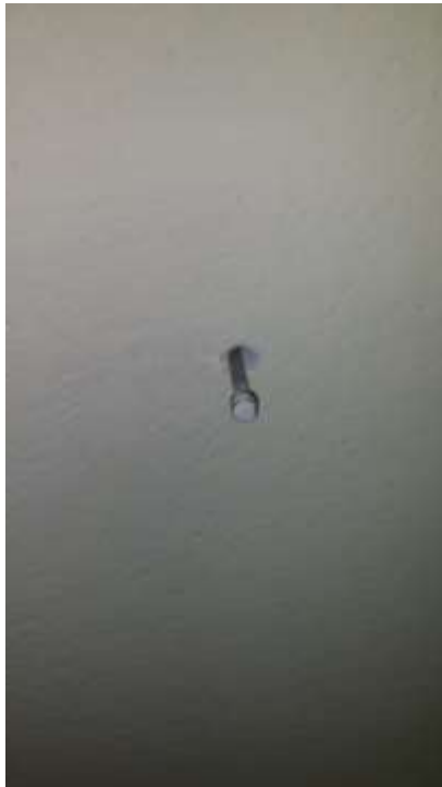
Perforación en pared interior.
