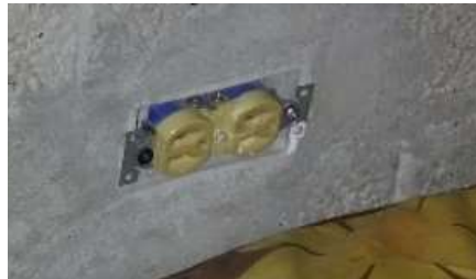
Tomacorriente defectuoso e incompleto.
