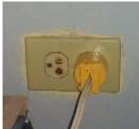
Tomacorriente defectuoso e incompleto.
