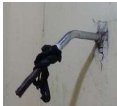
Elementos de la ducha defectuosos.
