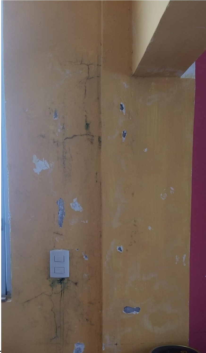
Efecto de capilaridad en la pared.
