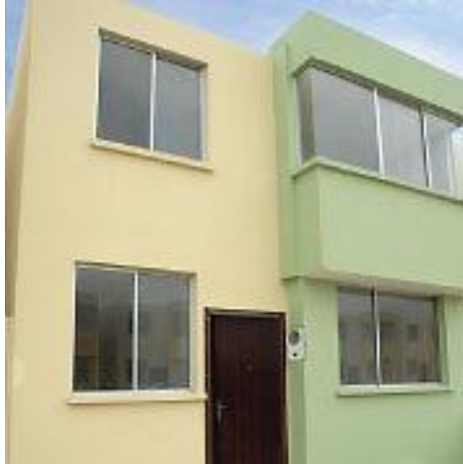
Figura 6. Fachada de dos niveles terminada.
