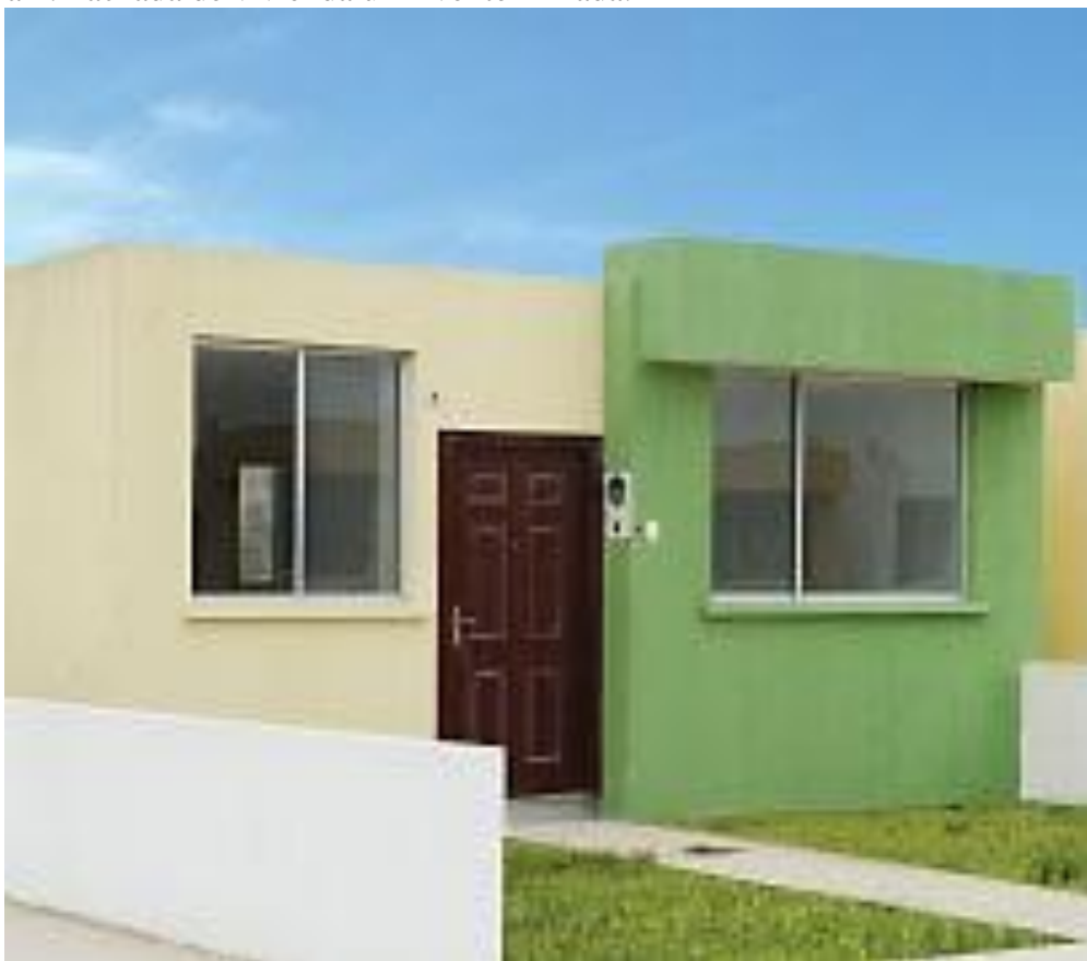
Figura 4. Fachada de vivienda un nivel terminada.
