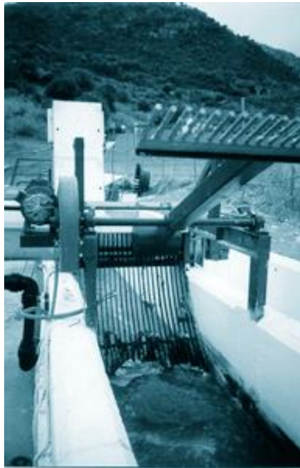
Figura N.2. Reja curva de accionamiento automático.
