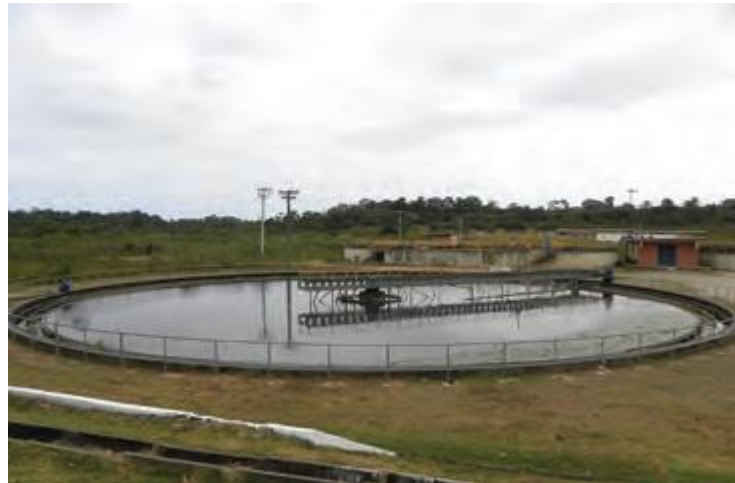
Figura N. 6. Sedimentador de la planta de tratamiento de aguas residuales municipales, Brasil.
