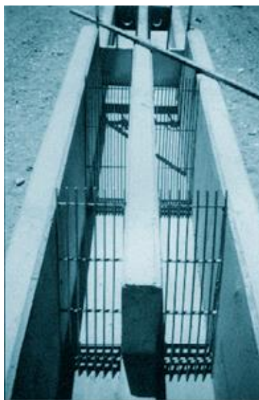
Figura N.1. Desbaste de gruesos seguido de desbaste de finos, empleando rejas rectas de limpieza manual.
