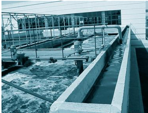
Figura N.5. Desarenador-desengrasador aireado.
