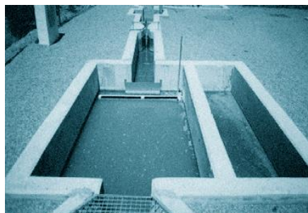
Figura N.4. Desengrasador estático.
