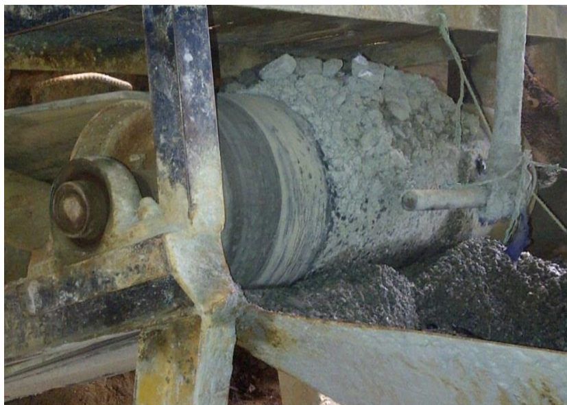
Anexo 1. Faja transportadora de entrada de material hacia el molino donde se tomó la muestra de alimentación.
