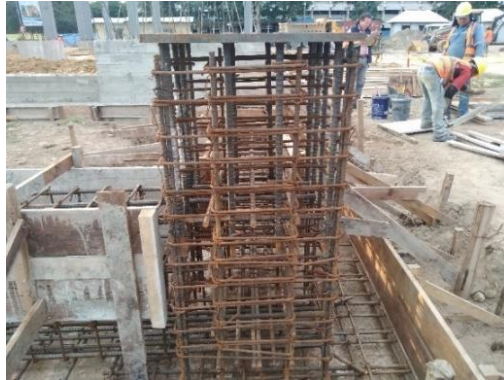
Ilustración 14: Armado de dado de columna.
