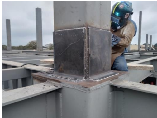
Ilustración 24: Cambio de sección de columnas.
