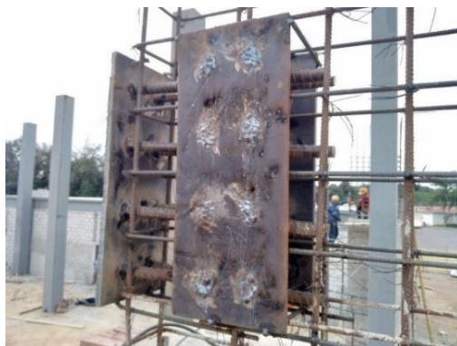
Ilustración 16: Placas de acero para conexión con vigas.
