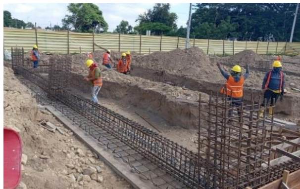
Ilustración 13: Armado de cimentación del edificio.
