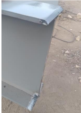
Ilustración 23: Biselado de viga de acero.
