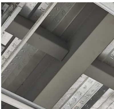
Ilustración 29: Conexión a corte viga secundaria – nervio.
