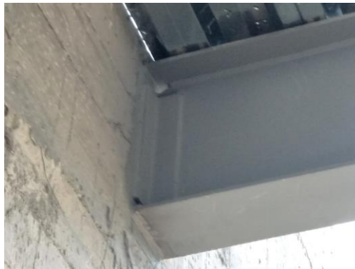
Ilustración 27: Conexión a momento viga – muro.
