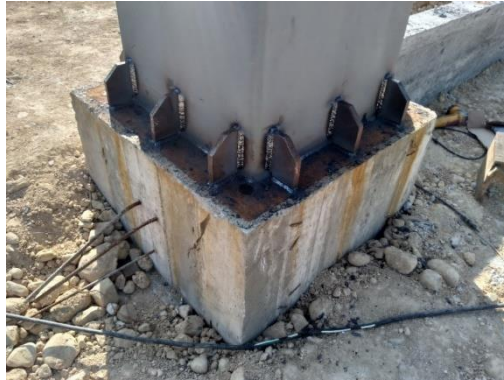
Ilustración 20: Conexión columna – placa base.
