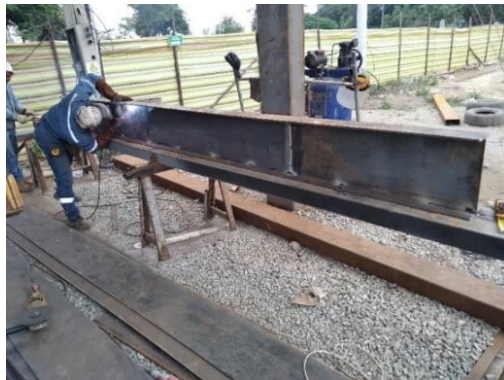
Ilustración 21: Armado de vigas de acero.
