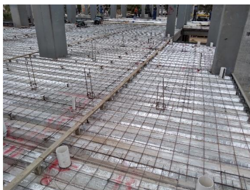
Ilustración 30: Losa tipo deck (placa colaborante).
