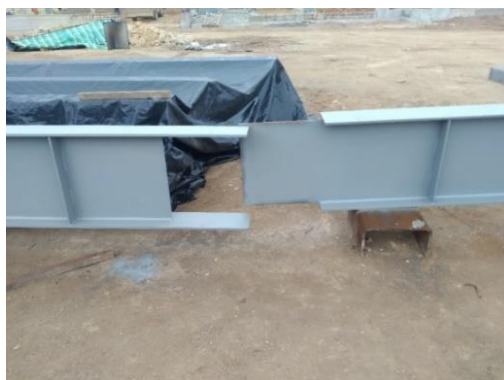
Ilustración 22: Empalme de vigas de acero.
