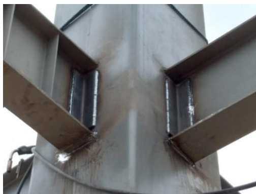
Ilustración 25: Conexión a momento de viga – columna.
