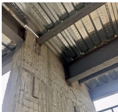
Ilustración 28: Conexión a momento viga – muro.
