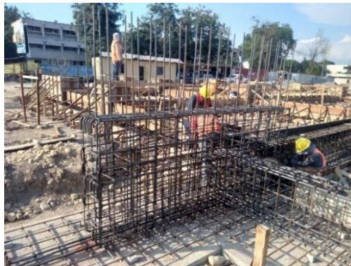
Ilustración 15: Armado de cimentación de muro.
