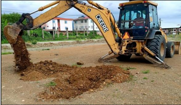
*Ilustración 22. Extracción de muestras con maquinaria pesada*
