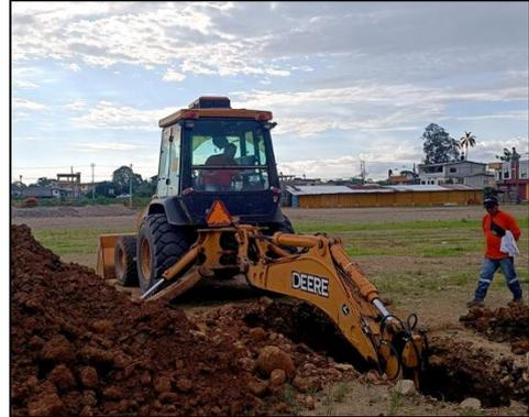
*Ilustración 24. Recolección de muestras para ensayos In Situ*
