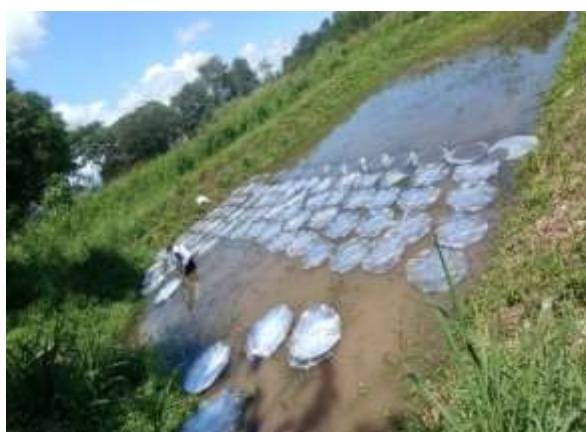
ANEXO 6 Instalación de manta solar 25% de cobertura.
