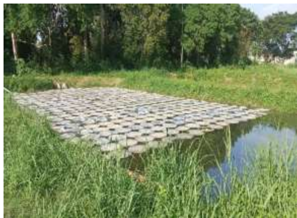
ANEXO 8 Instalación de manta solar 75% de cobertura.
