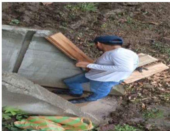
ANEXO 4 Instalación de tabloncillos en la compuerta del estanque para control de flujo.
