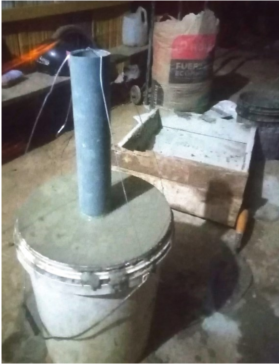
Ilustración 25 fundición de la base para la escultura fuente del autor 24/01/2025
