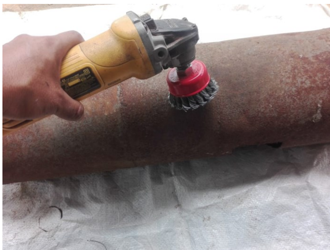
Ilustración 19 limpieza del óxido con máquina amoladora de 11000 rpm para empezar a soldar y proceder a aplicar la pintura Fuente: del autor 24/01/2025
