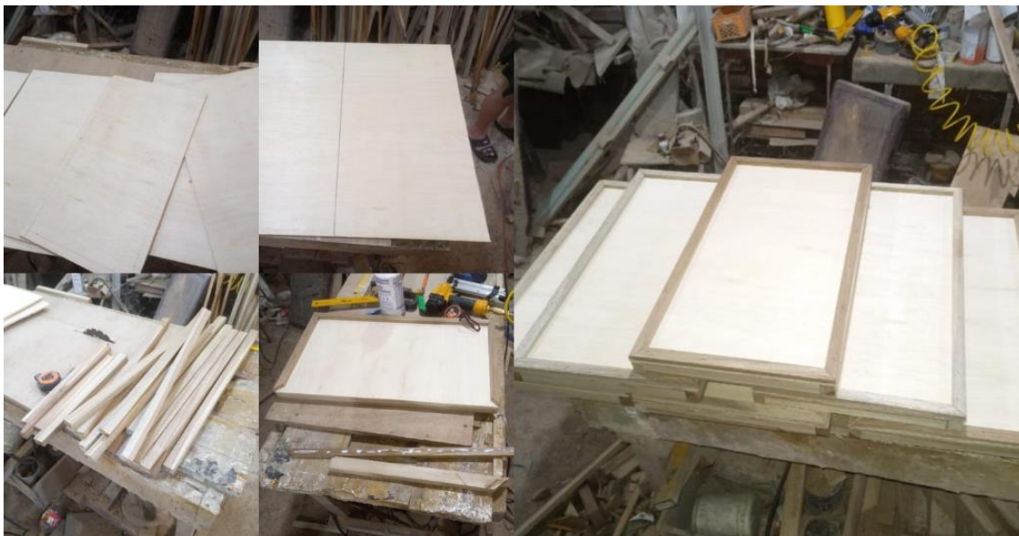
Ilustración 21 Elaboración de los marcos de madera. Fuente: Autor. (2025)
