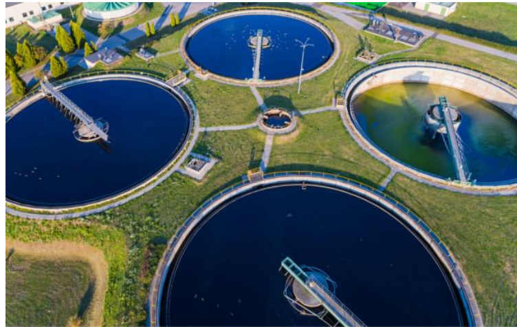
Figura 5 Piscinas de tratamiento de aguas.
