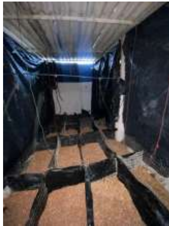
Anexo 4: Adecuación del galpón
