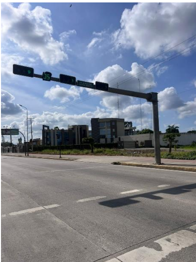
Figura 5: Ausencia de Señalizaciones aérea
