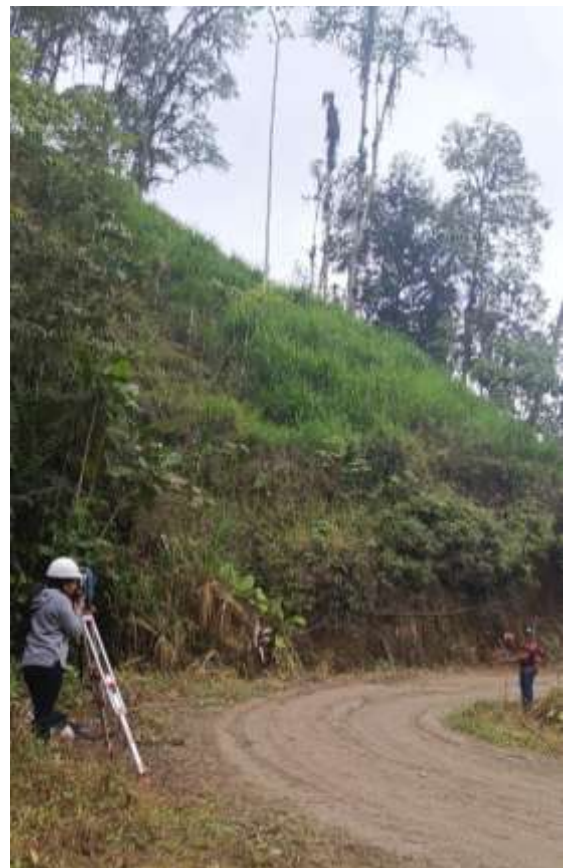
Anexo 6 Replanteo con Estación Total SOKKIA CX105
