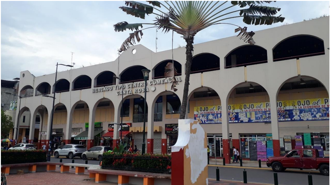
Ilustración 33.- Vista frontal de la edificación.
