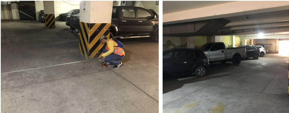
Ilustración 39.- Vista interior y medición de eje entre columnas del estacionamiento.
