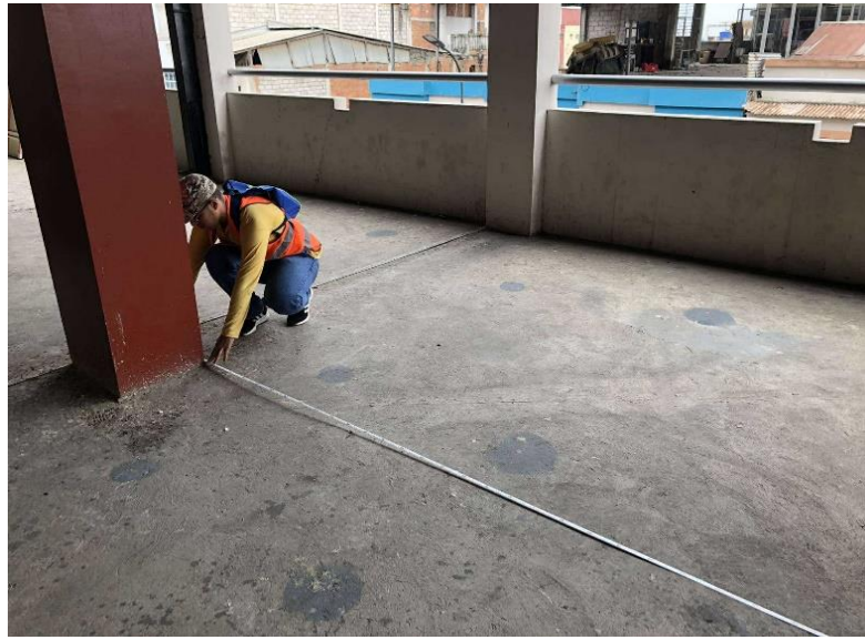
Ilustración 47.- Medición de ejes entre columnas correspondientes a la 2da planta alta del Bloque N°3.
