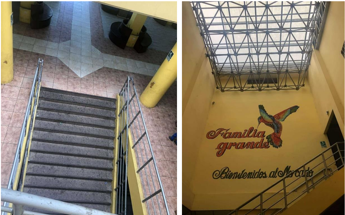
Ilustración 42.- Vista interna de elementos y detalles estructurales en 1era planta alta del bloque N°3.
