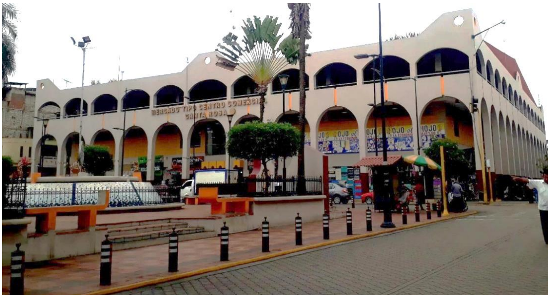
Ilustración 34.- Vista de la esquina frontal derecha para la edificación bajo estudio.
