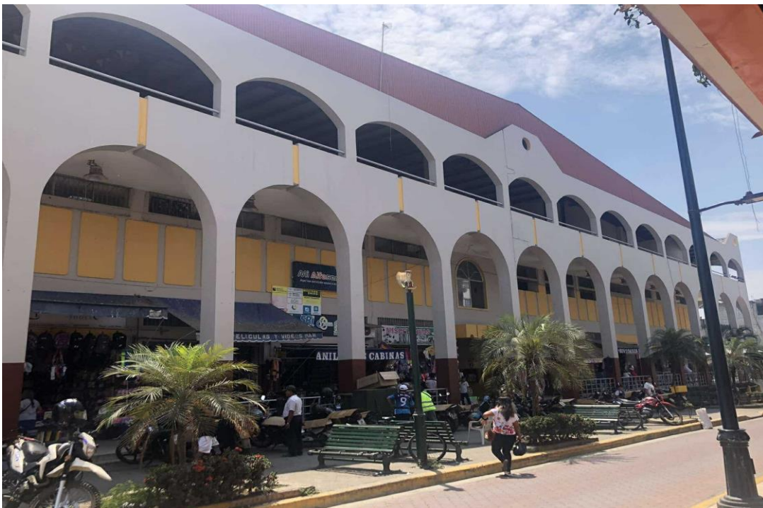
Ilustración 36.- Vista lateral derecha de la edificación.
