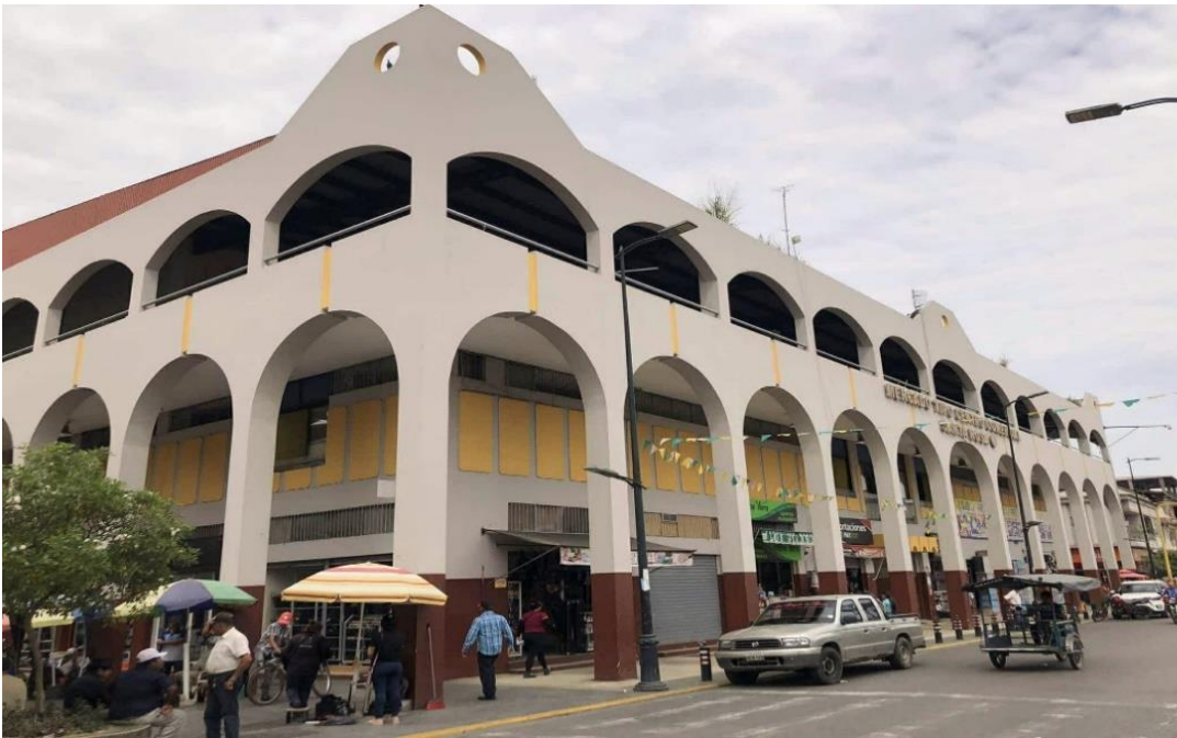
Ilustración 35.- Vista de la esquina frontal izquierda para la edificación bajo estudio.
