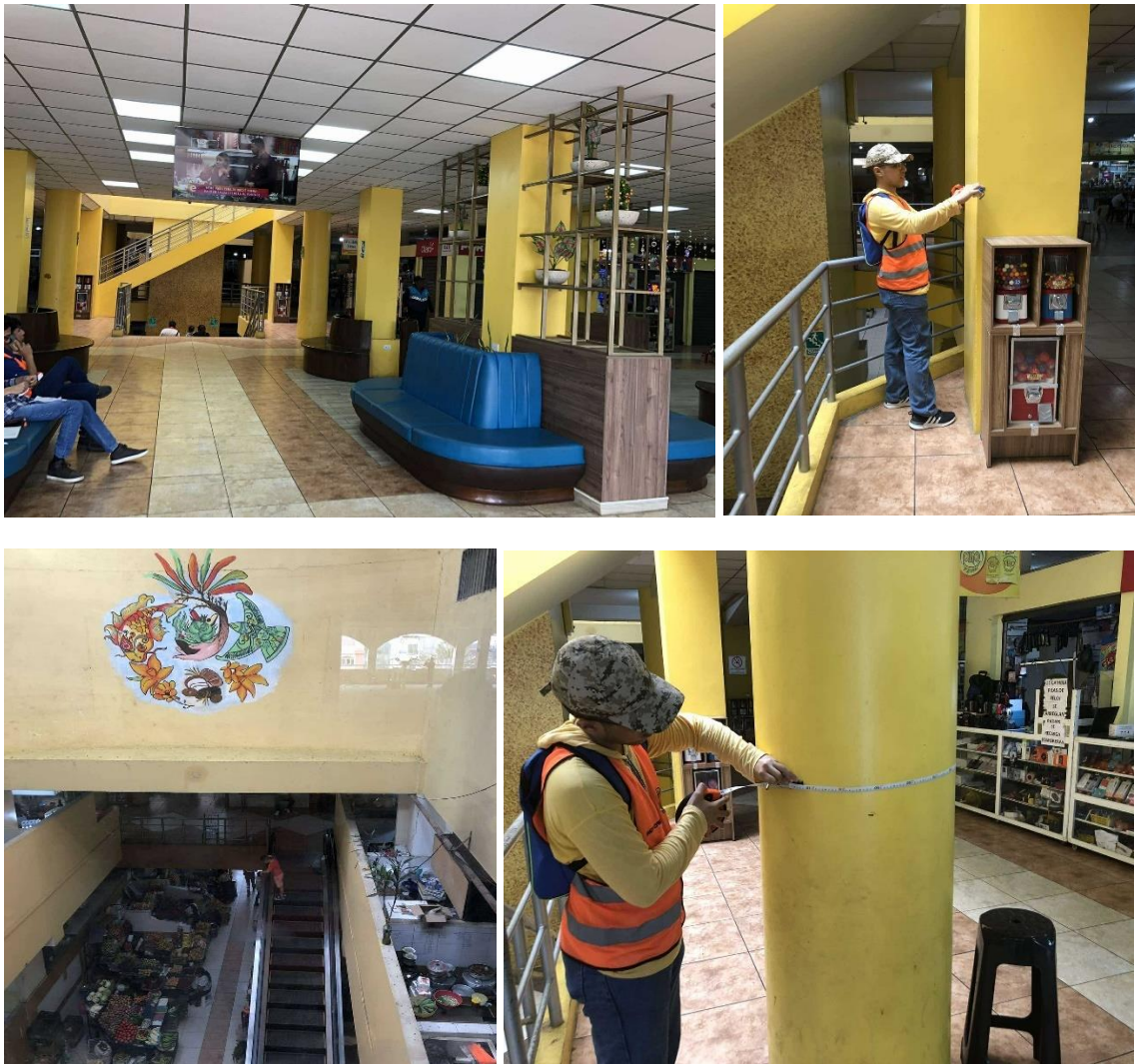
Ilustración 43.- Vista interna correspondiente a 1era planta alta del bloque N°3 y medición de sección en columnas para su verificación.
