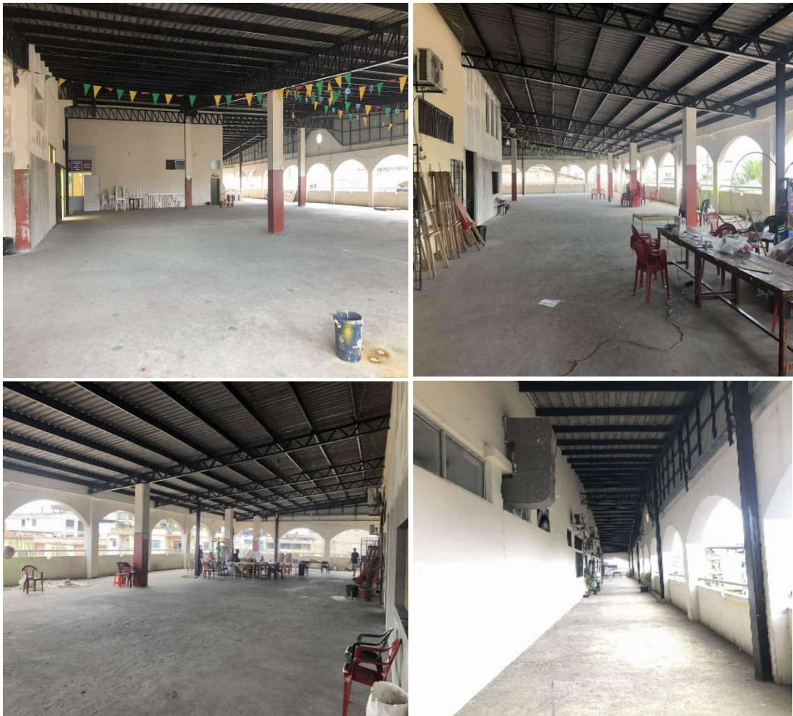
Ilustración 45.- Vista interna correspondiente a 2da planta alta del bloque N°3 y verificación de información en elementos estructurales.
