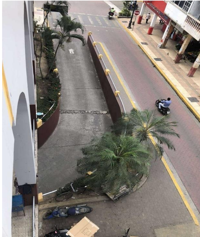
Ilustración 37.- Entrada derecha del estacionamiento subterráneo en la edificación.
