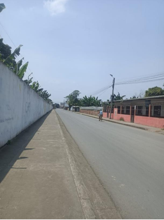
Figura 18. Calle valencia sin señalización
