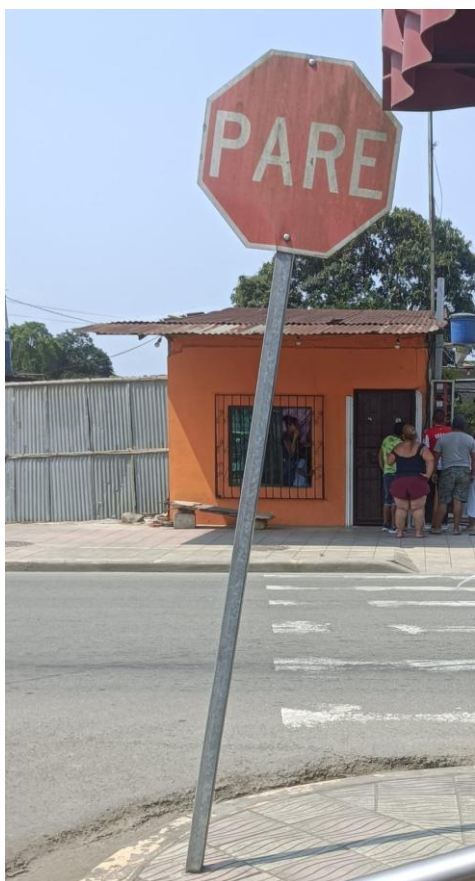
Figura 16. Señal vertical crítica.
