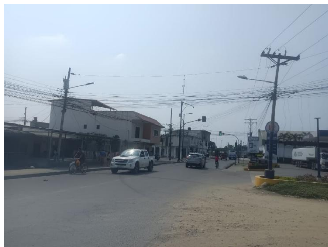
Figura 15. Calle Bolívar sin señal horizontal
