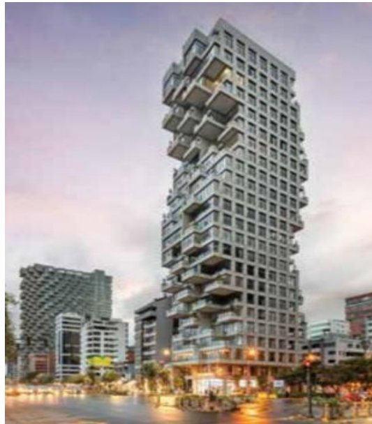
Figura 6. Edificio Qoner, Quito
