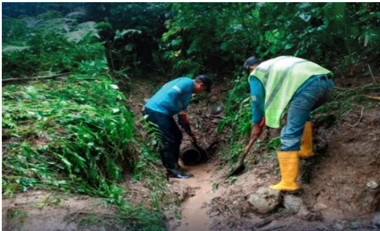
Ilustración 1 Obreros de mantenimiento retirando sedimentos
