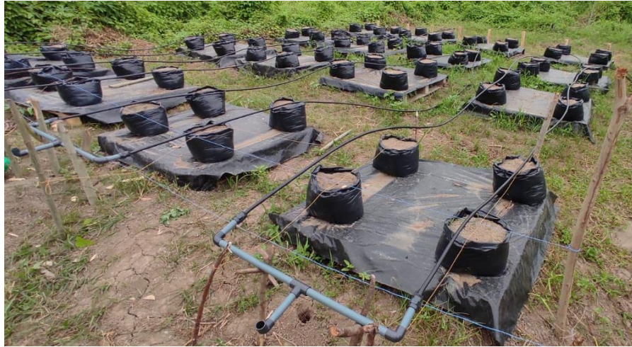
Anexo 5. Instalación de sistema de riego.
