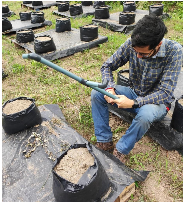
Anexo 4. Instalación de sistema de riego
