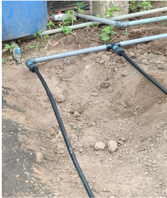
Figura 8. Instalación de laterales del riego por goteo
