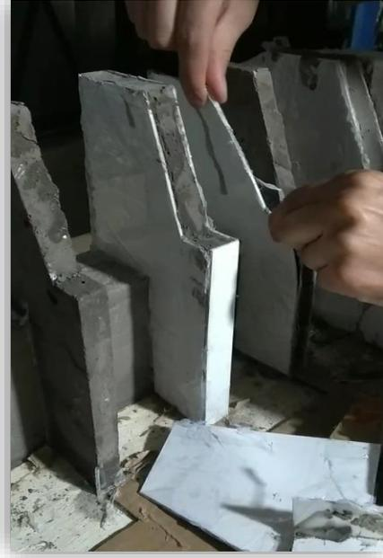
**Imagen 19.** Desencofrado de muros de compuertas.
