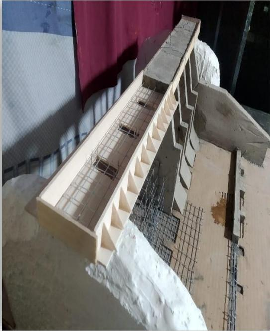
**Imagen 22.** Vista preliminar fundido de muros y losa de vía.
