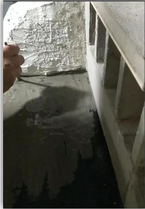
**Imagen 23.** Preparación e impermeabilización del área de embalse.
