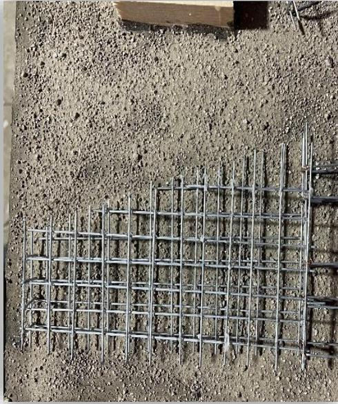
**Imagen 10.** Armado de muro lateral.
