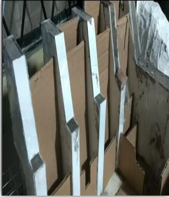
**Imagen 18.** Fundido de muros de compuertas.
