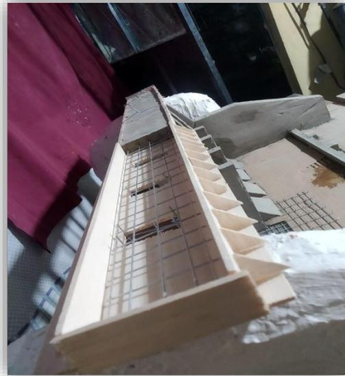
**Imagen 21.** Encofrado losa de vía.
