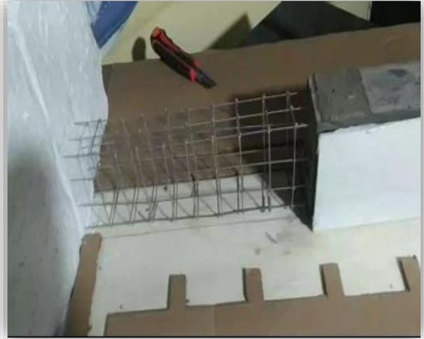
**Imagen 15.** Armado y encofrado de viga principal.
