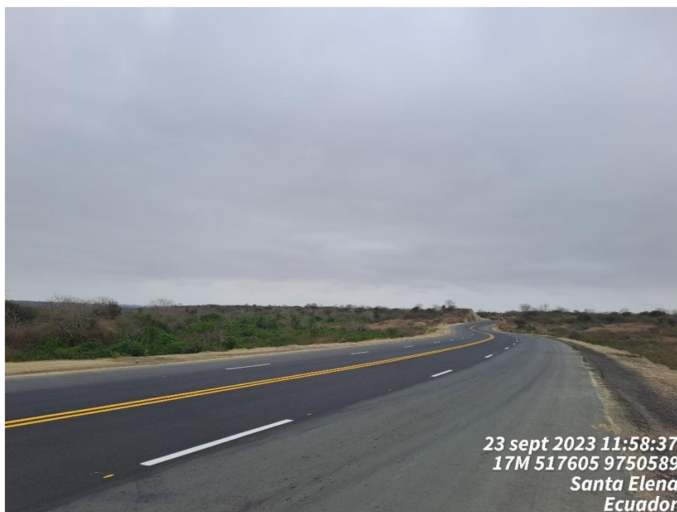
Ilustración 7 Vía utilizada para extracción de material PAR
