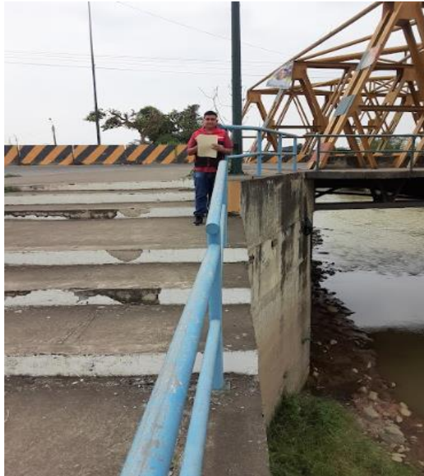
Ilustración 10 Observación de la baranda
