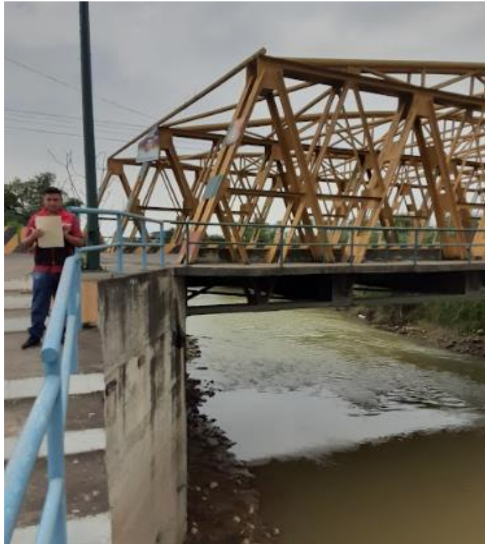
Ilustración 12 Observación de las vigas
