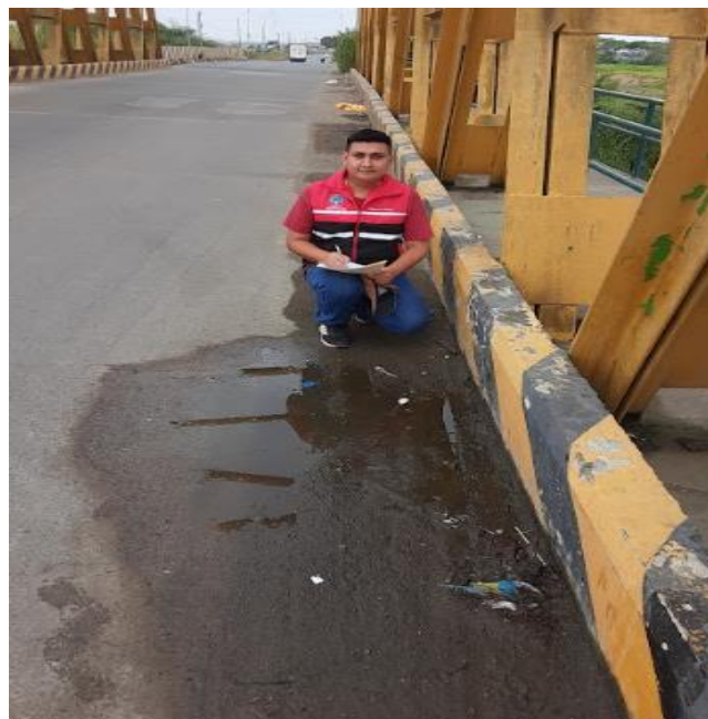
Ilustración 13 Inspección del drenaje
