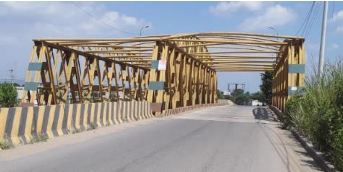
Ilustración 5 Estado actual del puente
