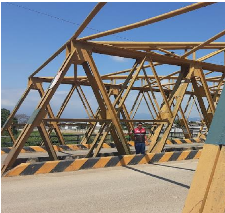
Ilustración 9 Inspección de la superestructura del puente
