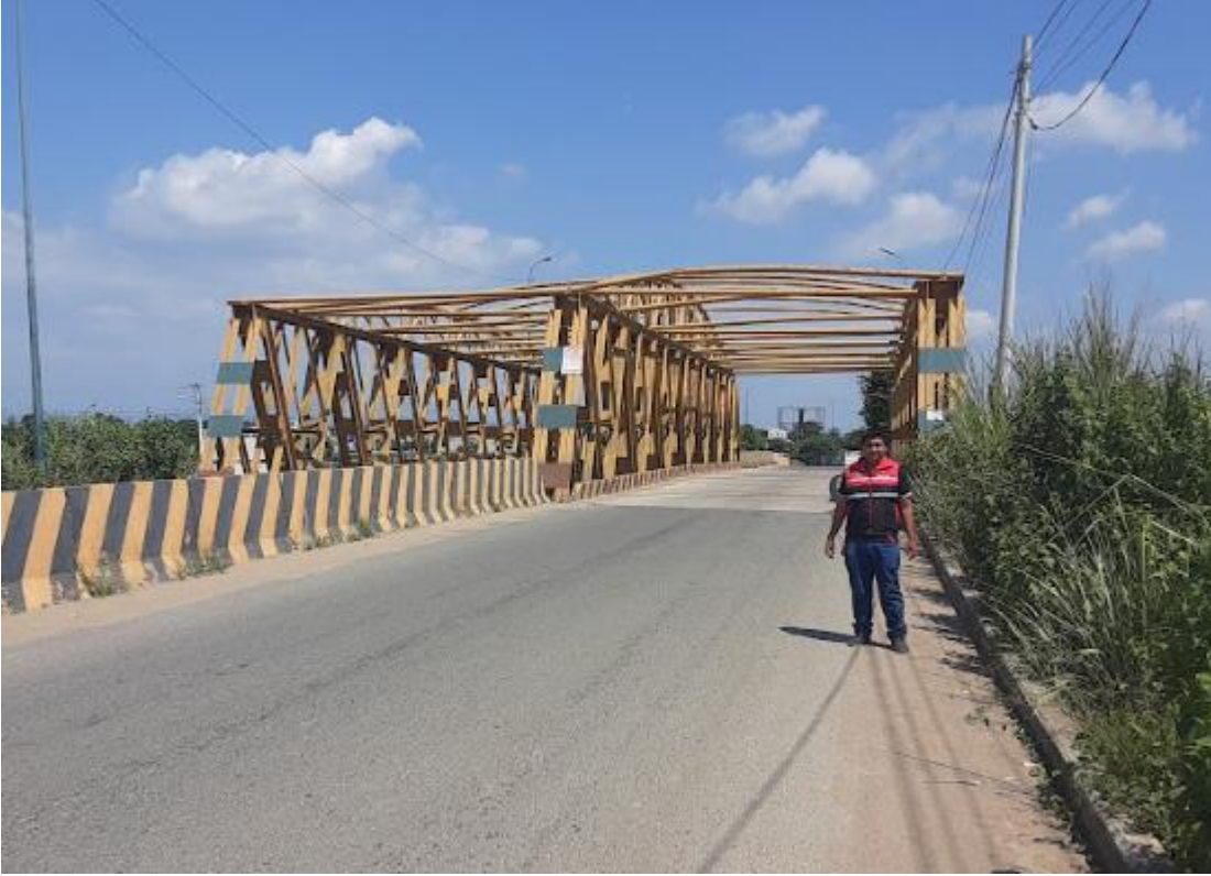
Ilustración 4 Puente Rio Pital
