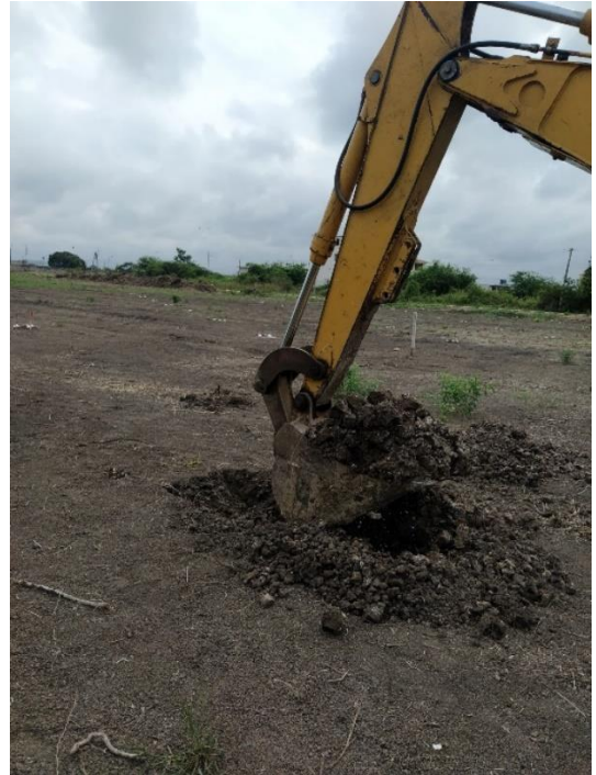
Ilustración 51. Recolección de muestras del suelo mediante maquinaria pesada
