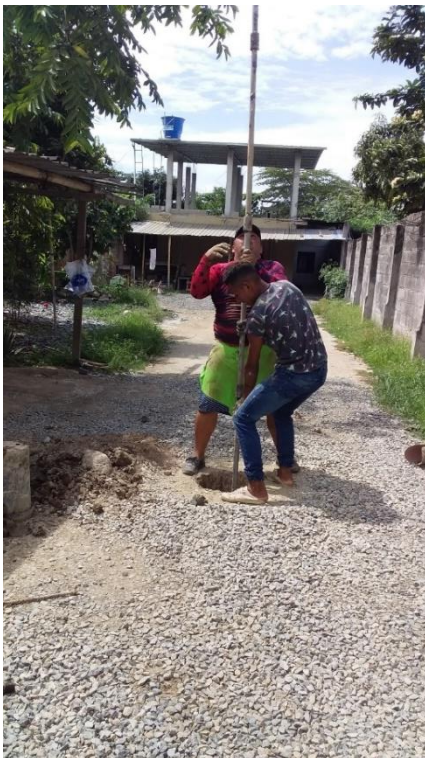
Ilustración 42. Ensayo de penetración estándar (SPT)
