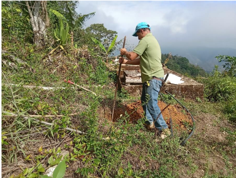
Ilustración 21: Toma de muestra de calicata-Evidencia 1
