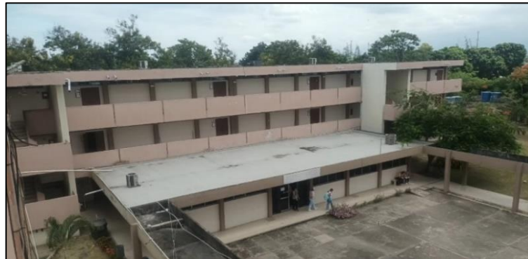
Ilustración 15 Aulas de la facultad de Ingeniería Civil
