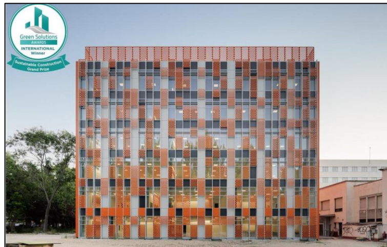
Ilustración 7 Aulario IndUVA - Valladolid
