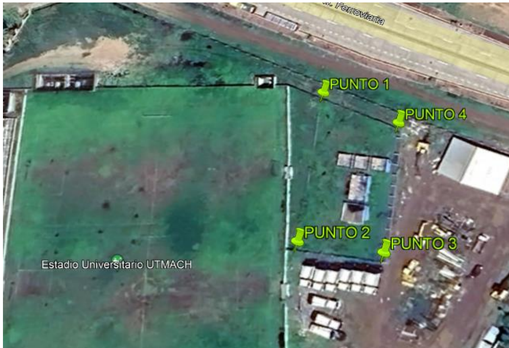
Figura 3. Puntos de georreferenciación de la Planta de Tratamiento de Aguas Residuales
