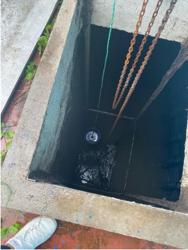
Figura 6. Realizando la medición de caudal en el afluente de la Planta de Tratamiento
