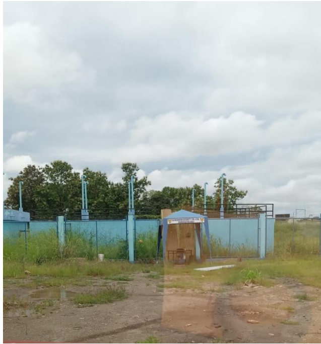
Figura 1 Exteriores de la planta de Tratamiento que se encuentran llenos de maleza
