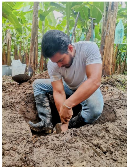
Figura 5: Realización de calicata Fuente: El Autor
