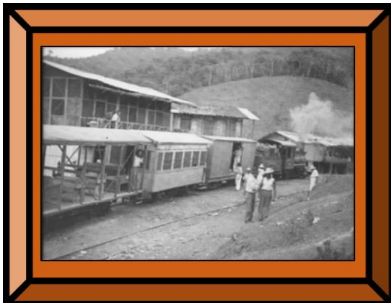
Ilustración 39 Locomotora trasladando vagones de carga
