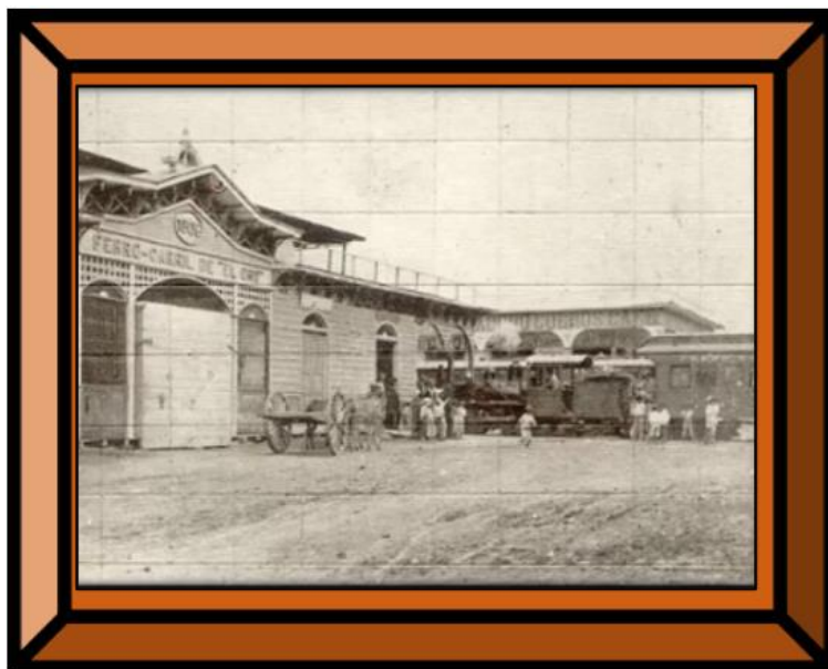
Ilustración 33 Estación Central del Ferrocarril en Machala.
