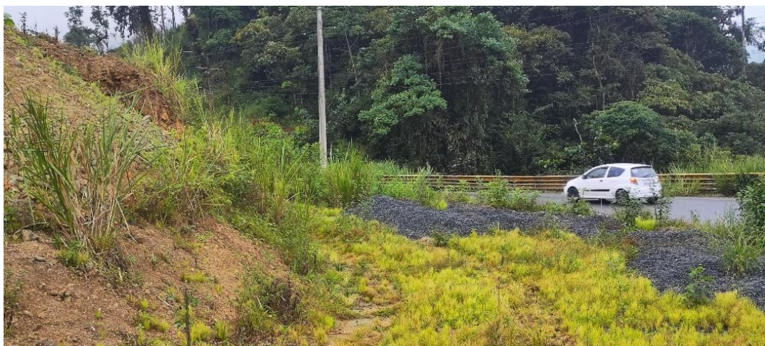
Anexo No. 09 y 10: Visita de campo ubicado a 80m. de taller “FRANCAR”.
