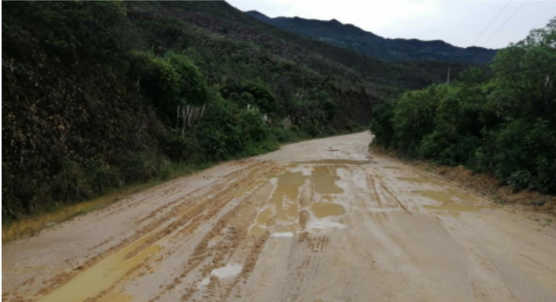
**Figura Nro. 22:** Estructura de vía sin drenaje en la carretera Chilla-Guanazan.
