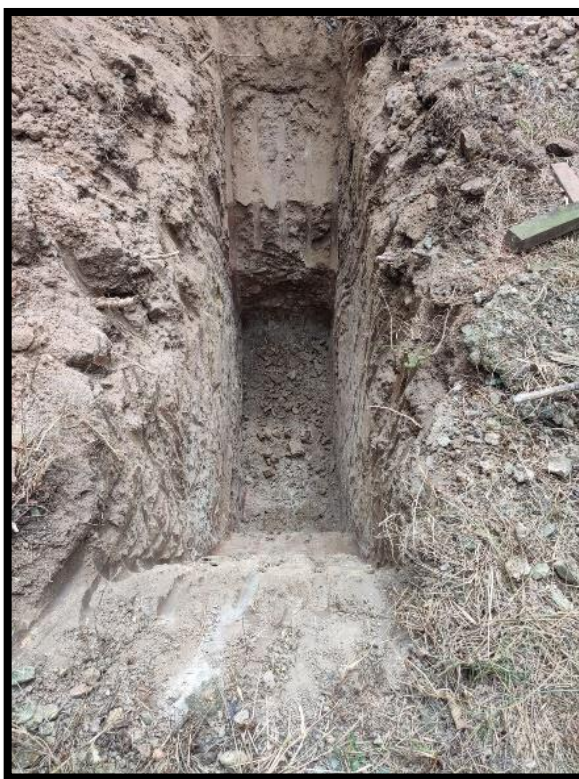
Anexo 4 Excavación para extracción de muestras
