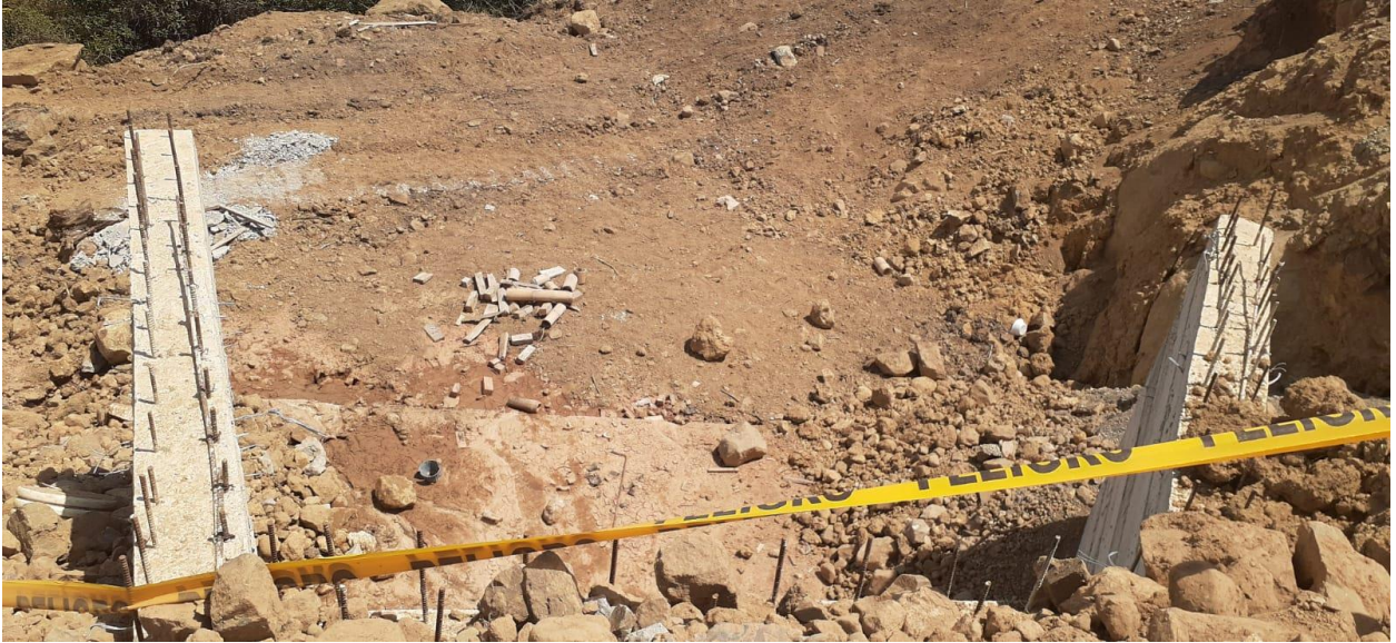
Anexo 3. Desembocadura de alcantarilla
