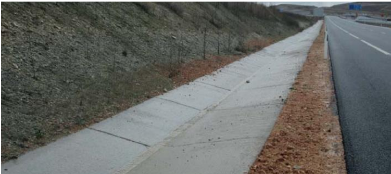
Gráfico 2. Drenaje longitudinal. Fuente: [6]
