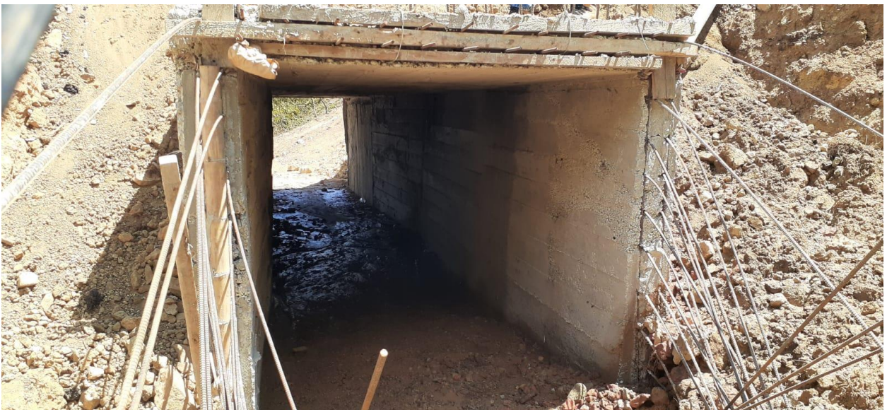
Anexo 6. Entrada de la alcantarilla
