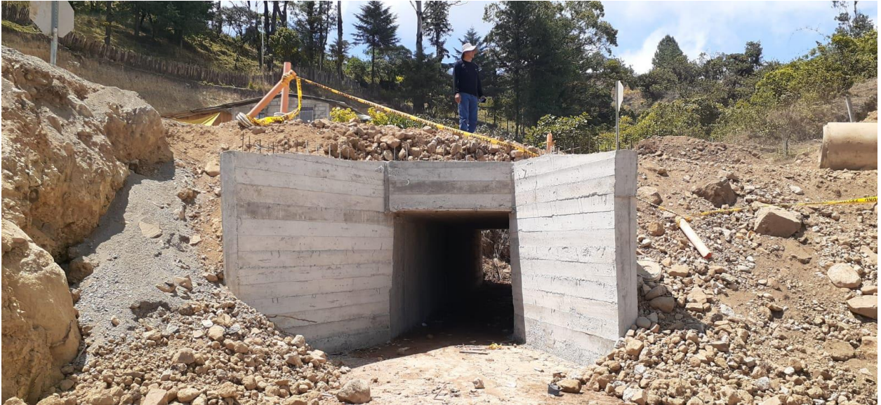
Anexo 5. Sección tipo cajón
