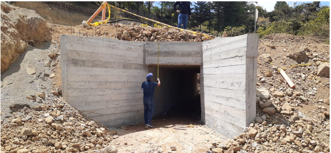
Anexo 4. Toma de medidas de alcantarilla.
