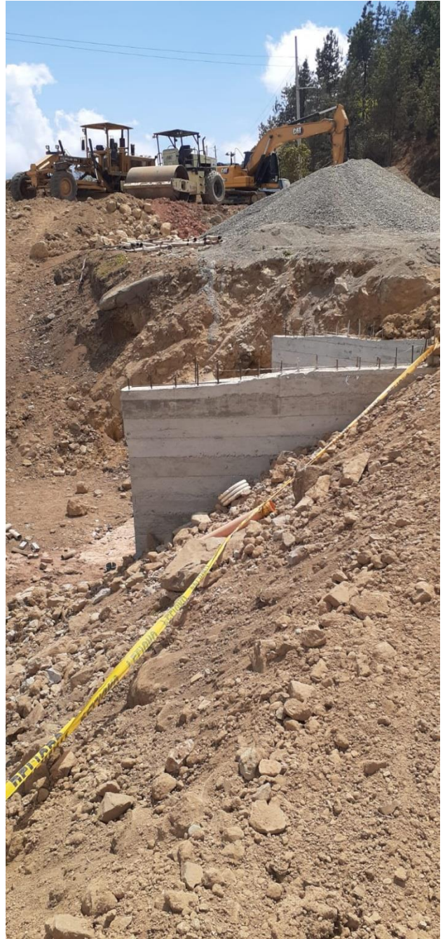
Anexo 2. Desembocadura de alcantarilla.
