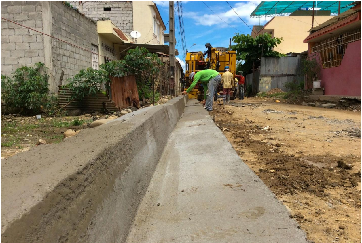
Gráfico 4. Elaboración de bordillos y cunetas. Fuente: Elaboración propia
