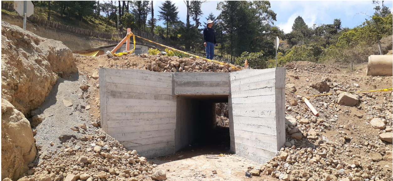
Gráfico 1. Drenaje transversal. Fuente: Elaboración propia
