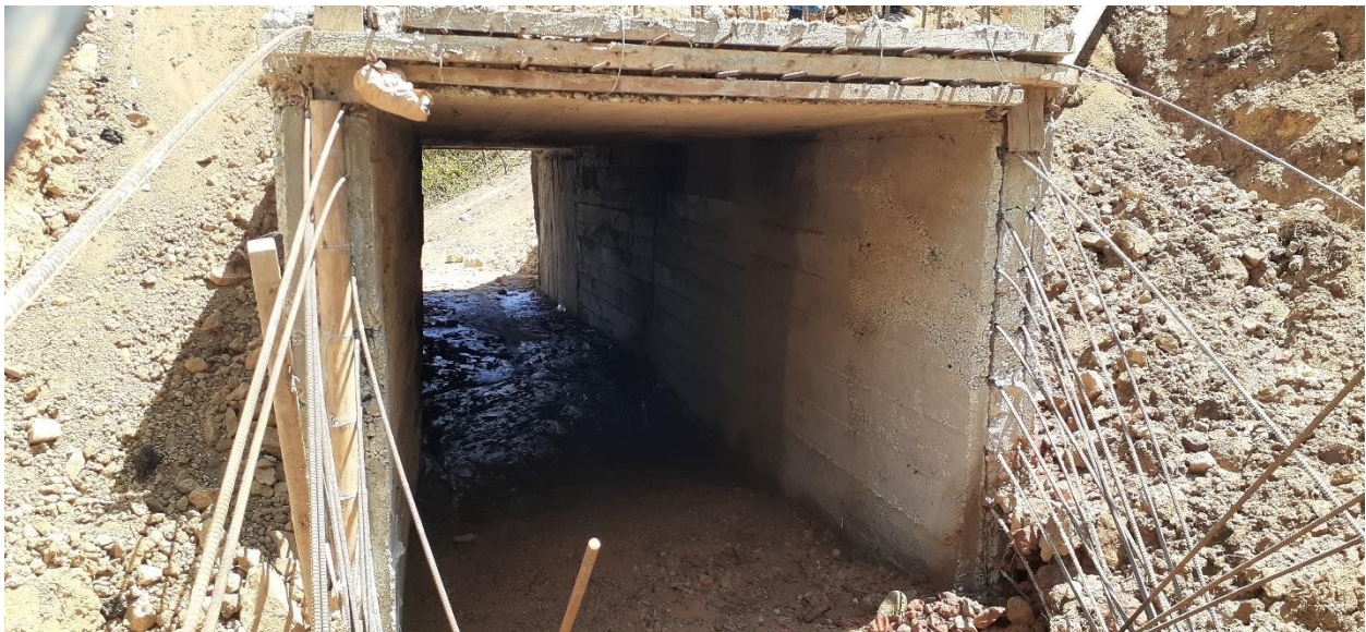
Gráfico 5. Drenaje tipo cajón en construcción. Fuente: Elaboración propia
