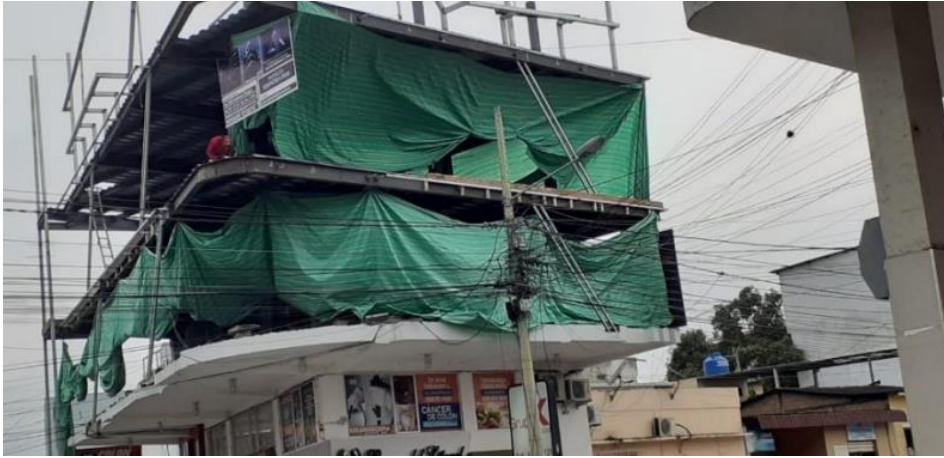
Anexo 1: Edificio en construcción
