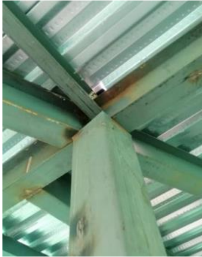
Anexo 4: Nudo rígido existente
