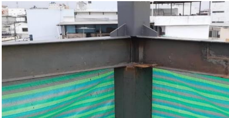
Anexo 5: Conexión viga-columna existente
