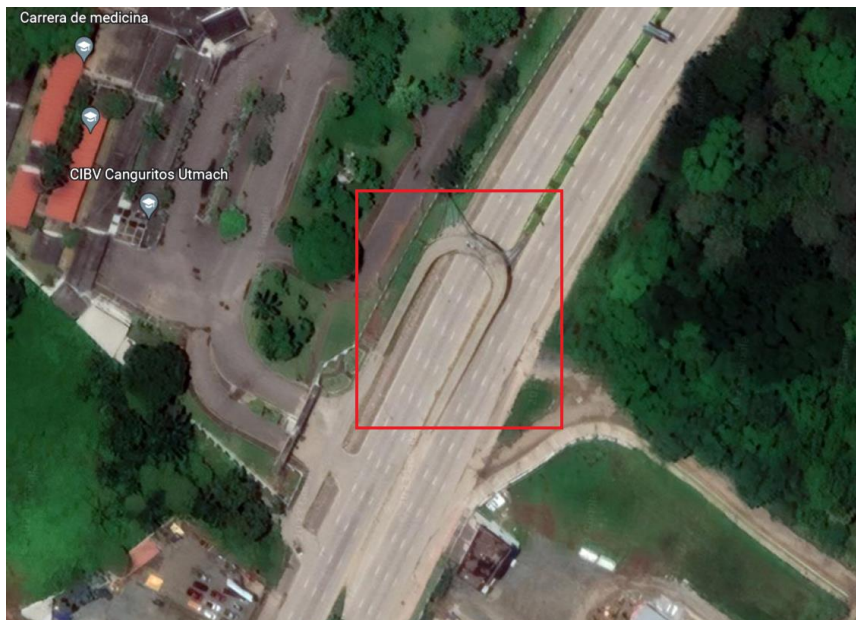
Ilustración 1: Puente vehicular de la Universidad Técnica de Machala.
