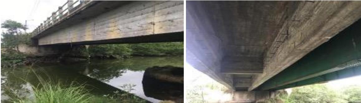
Mediante la revisión en el campo se constató como esta construido el puente y se observa en las imágenes tomadas como para su revisión se puede determinar cómo está conformado el puente existente con dos vigas metálicas y de hormigón, en la superestructura se ven como el hierro ya aparece y la junta del hormigón en el estribo.
