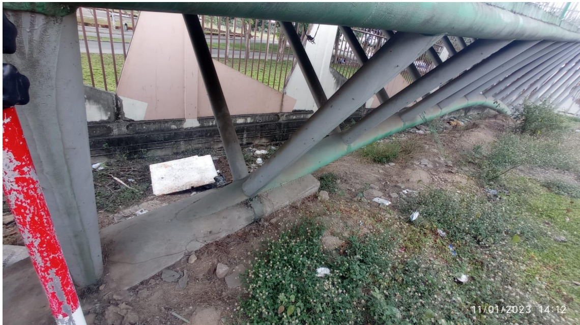
Figura 23: Elementos Estructurales que se aprecian debajo del puente [Elaboración Propia]
