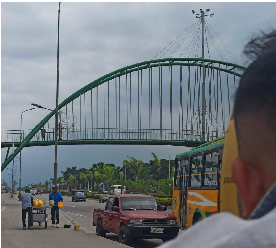
Figura 21: Toma de Puntos del elemento estructural del arco [Elaboracion Propia]
