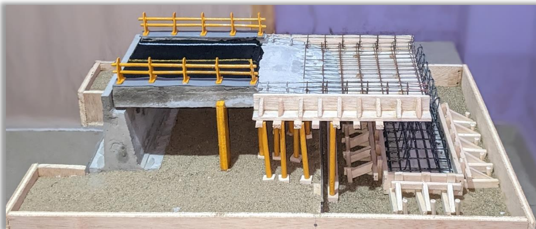
Imagen 39. Puente tipo losa modelo final
