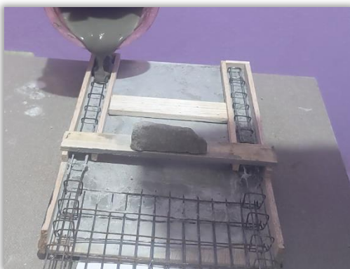
Imagen 27. Colado de hormigón en vigueta de baranda
