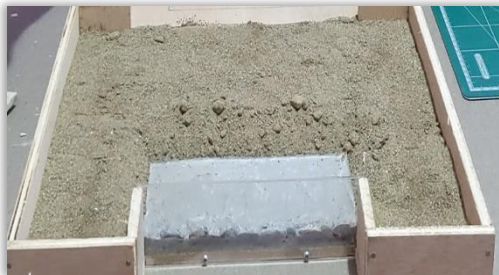
Imagen 21. Desencofrado de capa de hormigón ciclópeo
