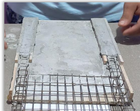
Imagen 28. Desencofrado de Losa
