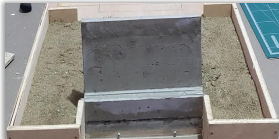
Imagen 22. Colocación de estribo sobre capa de concreto
