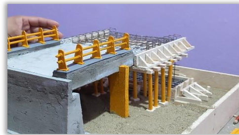
Imagen 34. Colocación de protecciones laterales de puente
