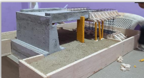
Imagen 33. Apuntalamiento de losa
