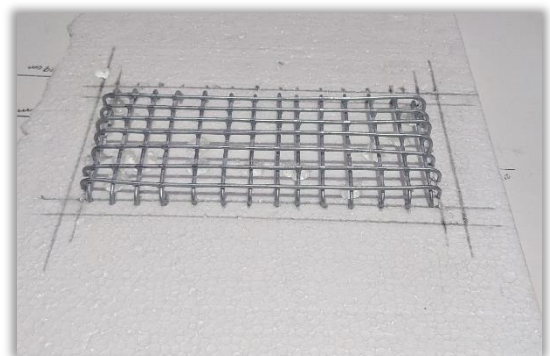
Imagen 2. Zapata de estribo
