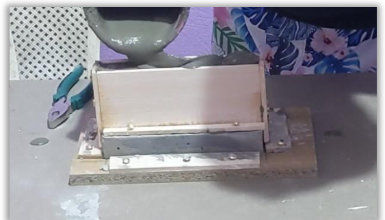
Imagen 10. Colado de hormigón en cuerpo de estribo
