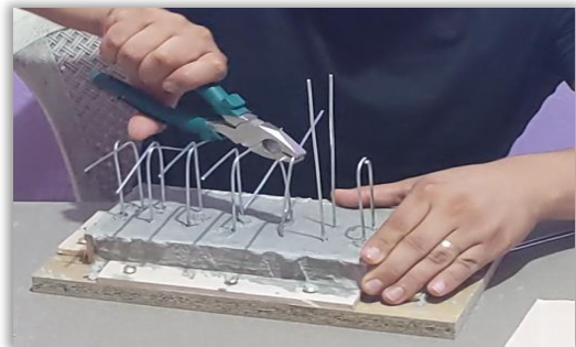
Imagen 6. Dobles de alambre para formar pila de estribo
