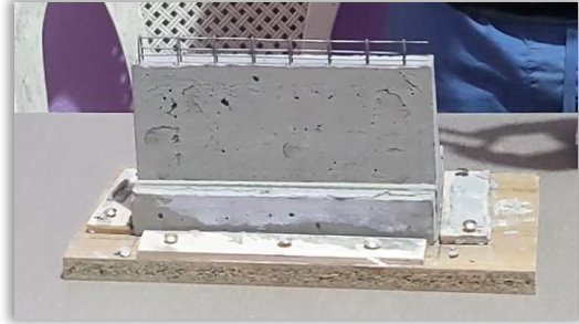
Imagen 12. Desencofrando cuerpo de estribo
