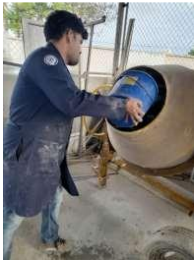
Anexo 8 Elaboración de la mezcla de concreto
