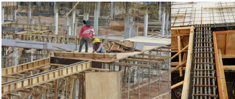
*Ilustración 2.2: Ejemplos de encofrados horizontales [10]*
