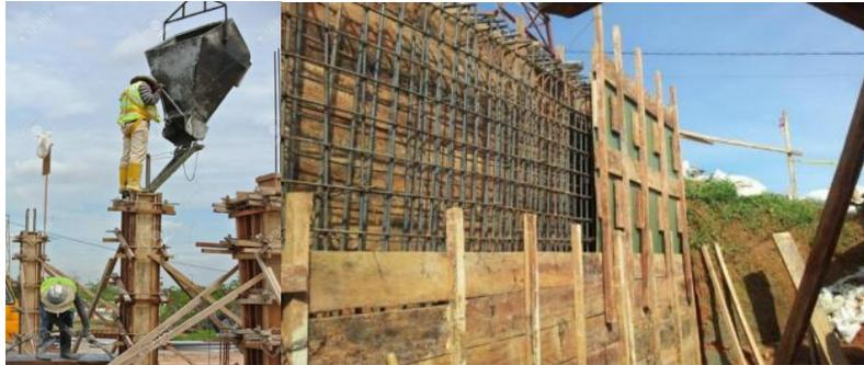
*Ilustración 2.1: Tipos de encofrados verticales [10]*
