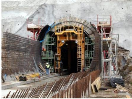
*Ilustración 2.3: Ejemplo de encofrados especiales [10]*
