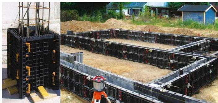
*Ilustración 2.5: Ejemplos de encofrados de plástico [10]*
