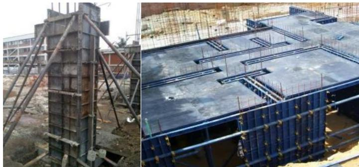
*Ilustración 2.4: Ejemplos de encofrados metálicos [10]*
