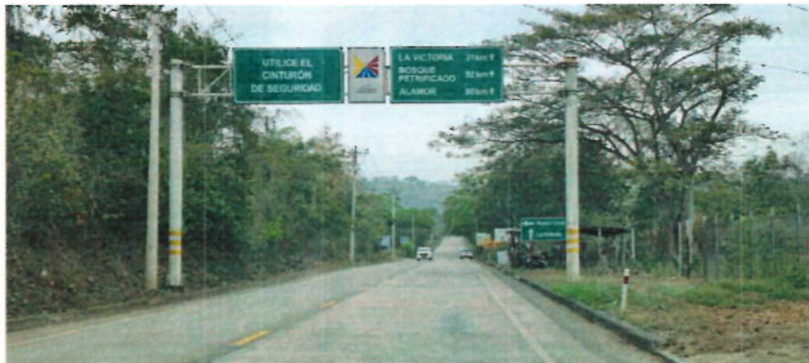
Ilustración 26 Fallas en vía a Arenillas
