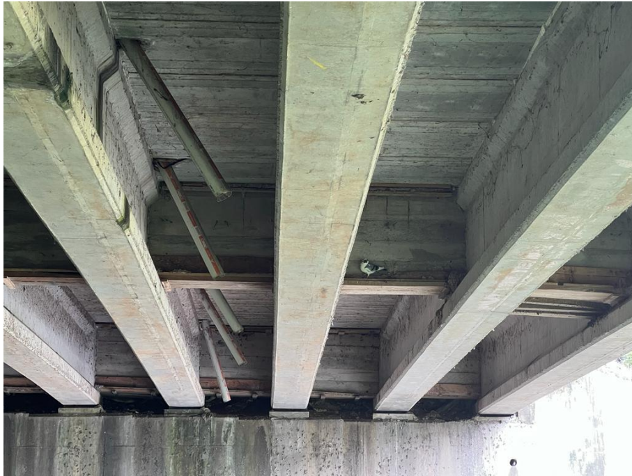
Ilustración 15 Drenajes aguas lluvias
