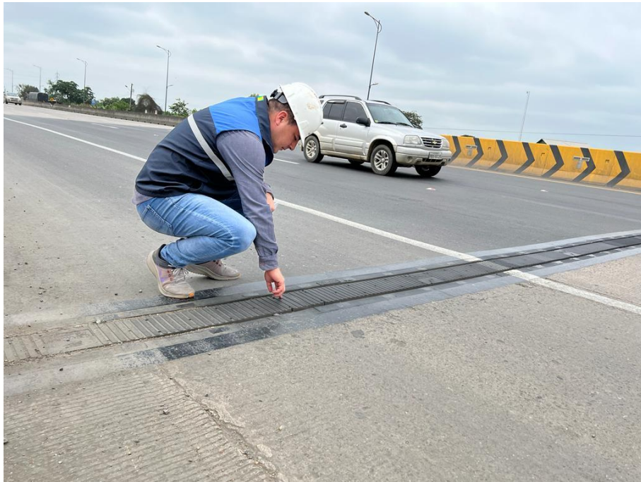
Ilustración 12 Observación de juntas de dilatación
