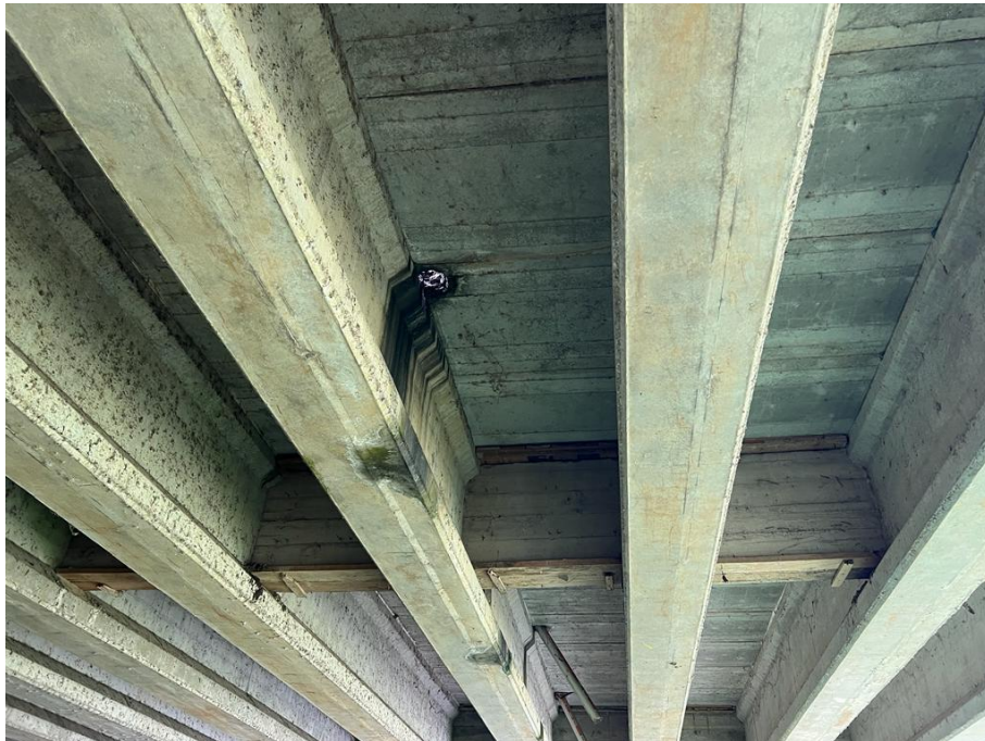
Ilustración 14 Drenajes de Aguas Lluvias
