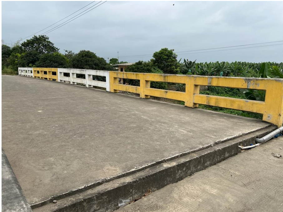
Ilustración 6 Barandas de protección
