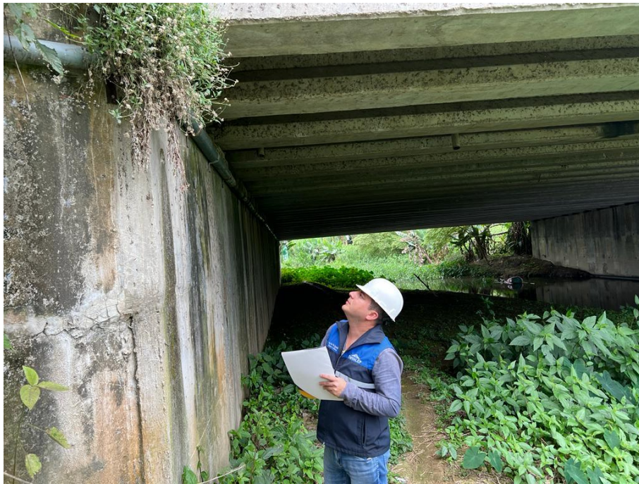
Ilustración 13 Observacion estado de Estribos y muro de ala
