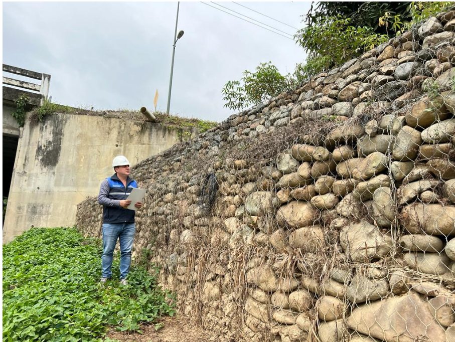
Ilustración 10 Registro de observaciones subestructura
