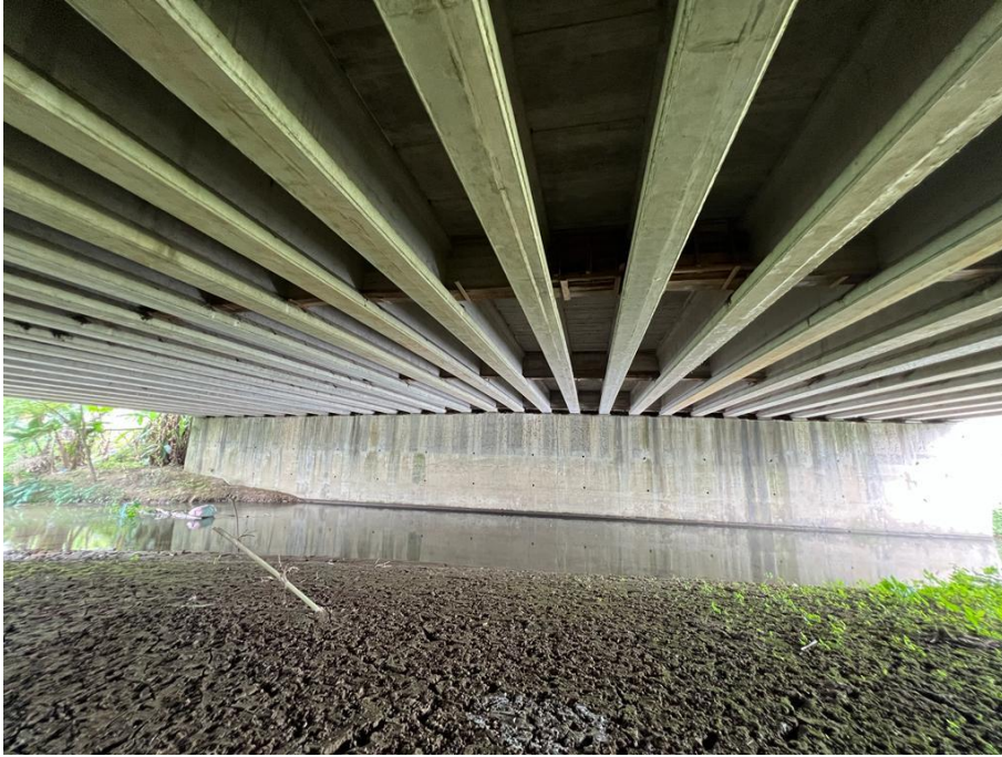
Ilustración 17 Vigas de puente rio Motuche
