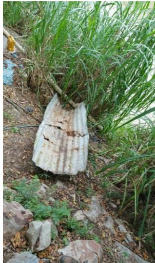
**Anexo 12.** Tubería de descarga de aguas residuales domesticas descargadas al río Jubones
