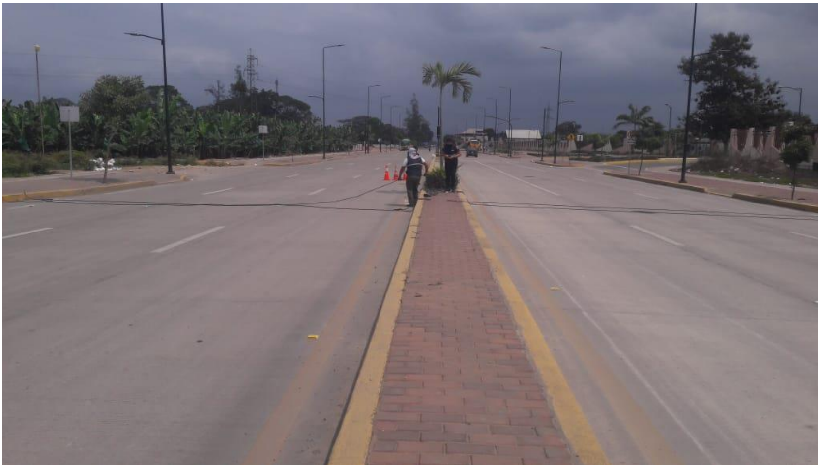
Ilustración 61 Instalación de equipo en Av. Ferroviaria
