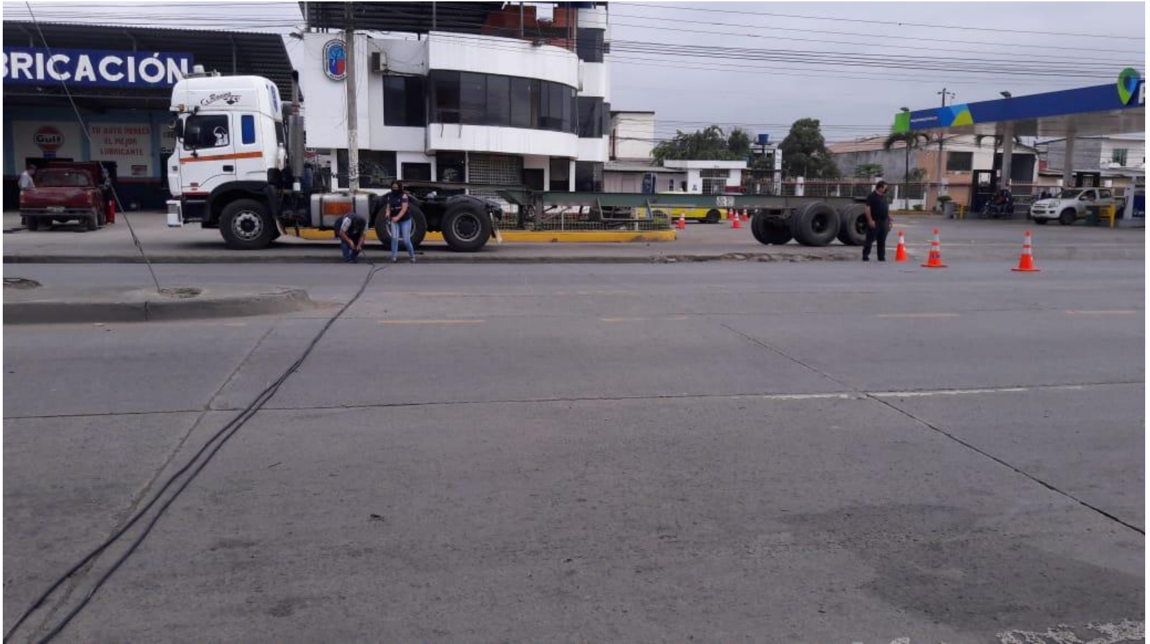
Ilustración 65 Instalación de equipo Av. Bolívar Madero Vargas
