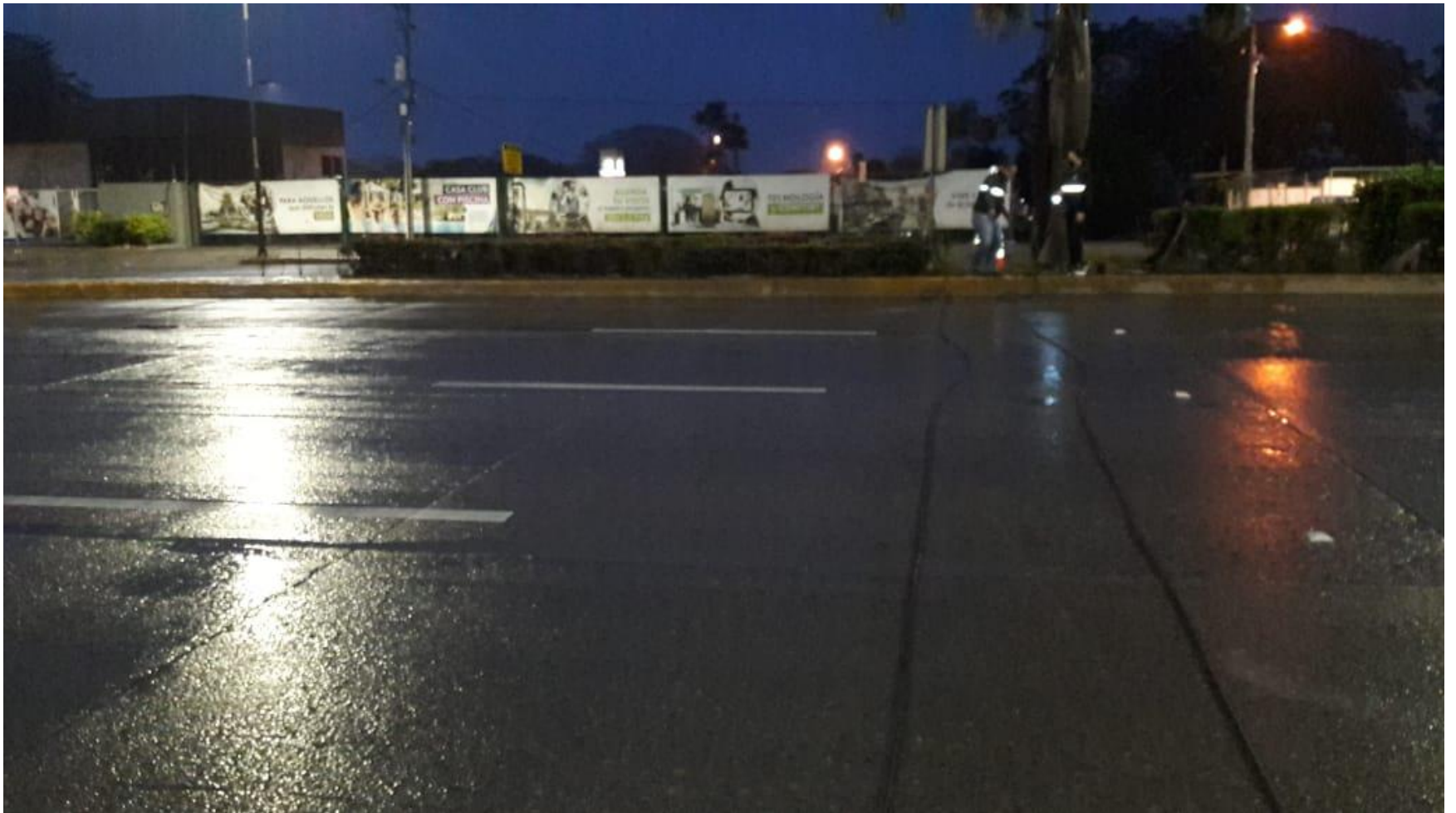
Ilustración 64 Instalación de equipo en Av. 25 de junio
