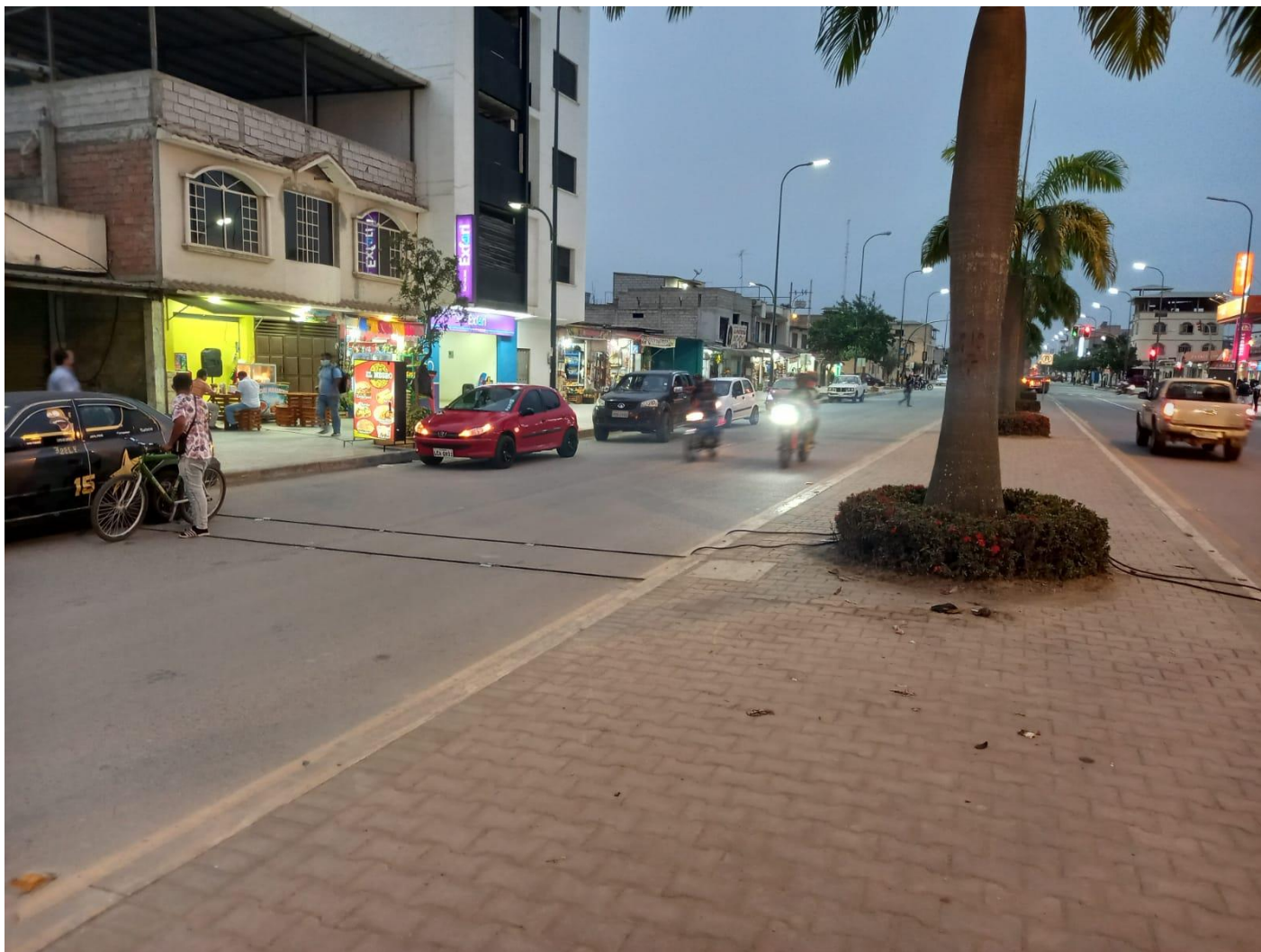
Ilustración 55 Equipo en funcionamiento Av. Colon Tinoco
