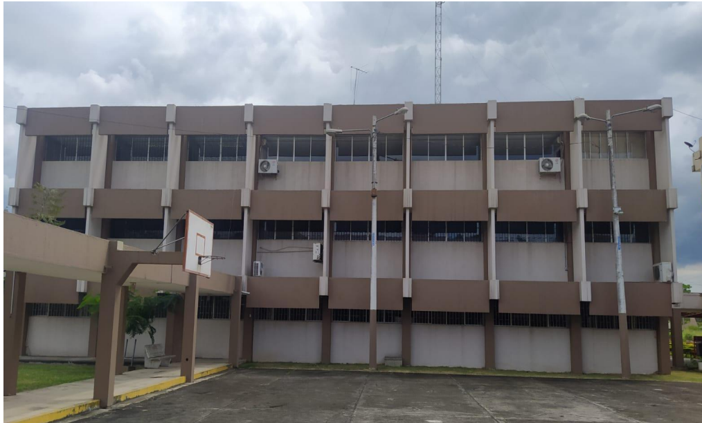
FIGURA 8. Fachada frontal del Edificio de laboratorios de la facultad de Ingeniería Civil
