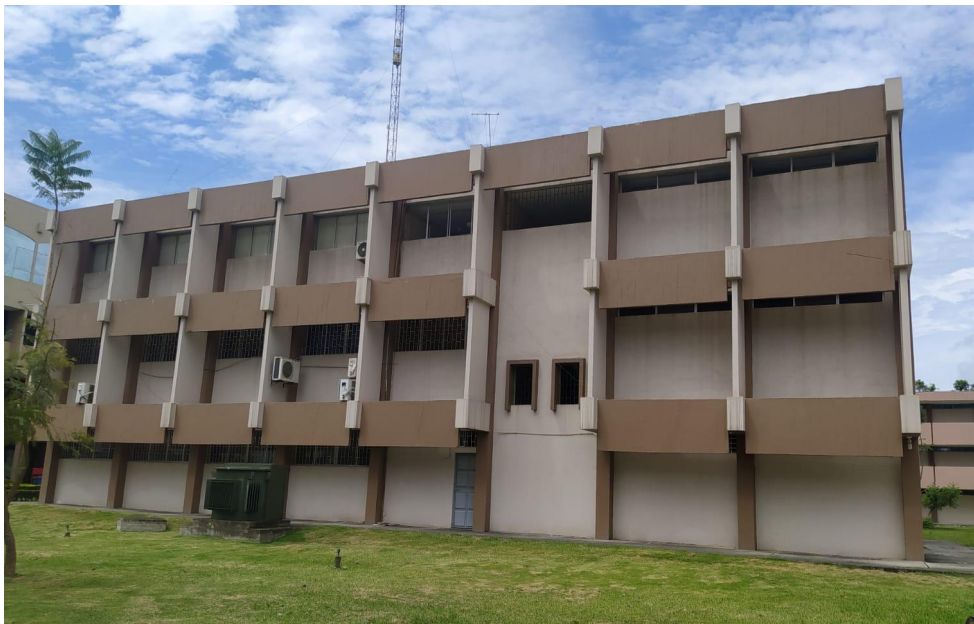
FIGURA 9. Fachada posterior del edificio de laboratorios de la Facultad de Ingeniería Civil
