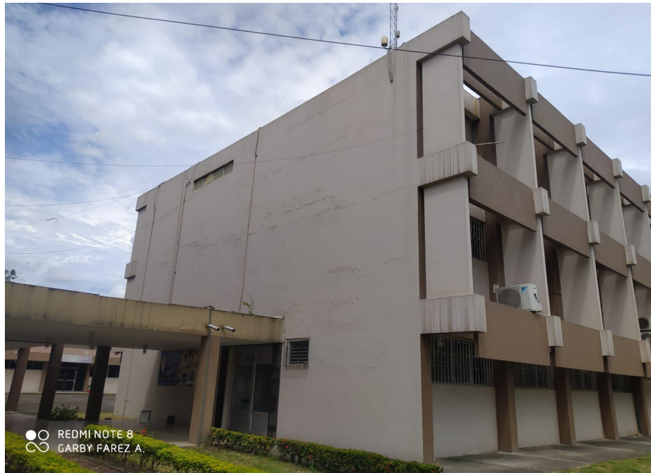
FIGURA 11. Fachada izquierda del edificio de laboratorios de la facultad de Ingeniería Civil
