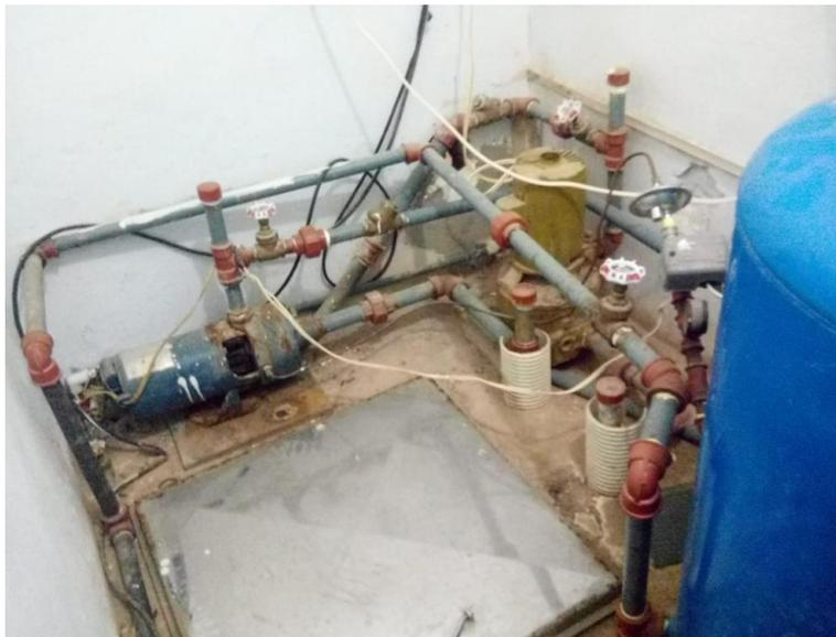
Foto 5. Mala estética de tuberías y cables de electricidad en el sistema hidroneumático.
