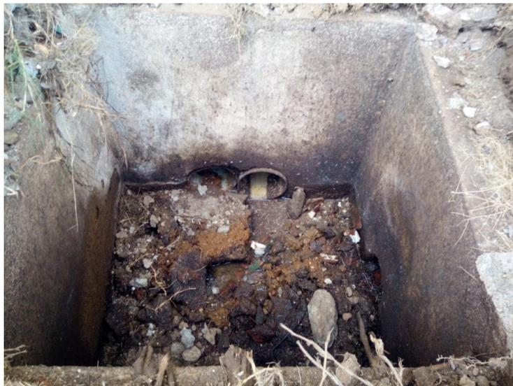
Foto 6. Caja de revisión con acumulación de sedimentos.
