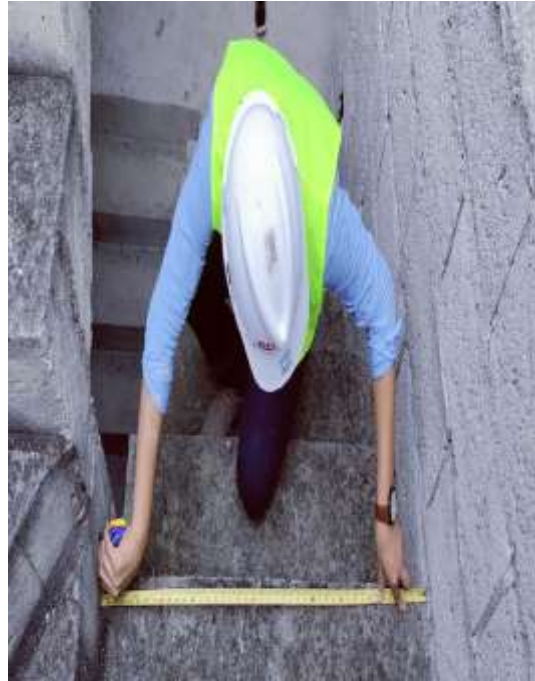
Ilustración 7: Medición de ancho de escalera
