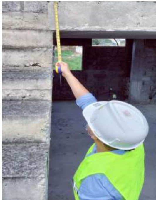
Ilustración 12: Medición de espesor de losa
