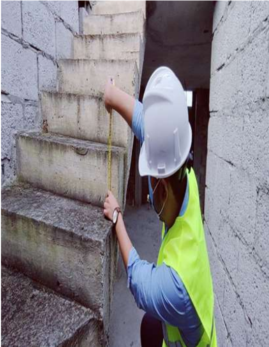
Ilustración 6: Medición de altura de contrahuella
