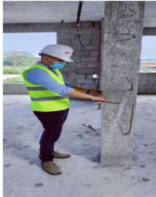
Ilustración 10: Medición de secciones de columna
