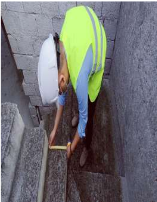
Ilustración 9: Medición de huella
