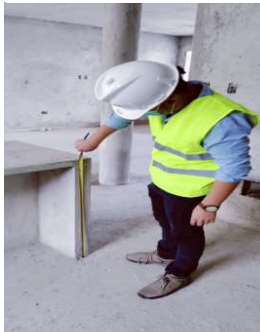
Ilustración 8: Medición de altura de mesón
