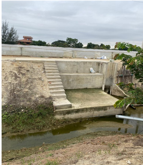
Figura 7. Compuerta de las piscinas camaroneras CAVIPRO
