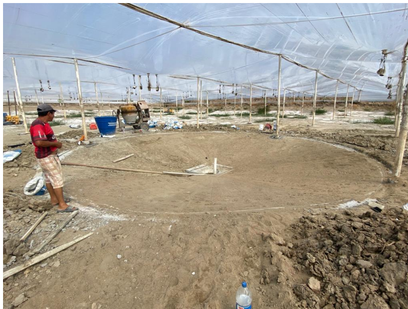
Figura 4. Construcción del sistema de sifoneo camaronera CAVIPRO
