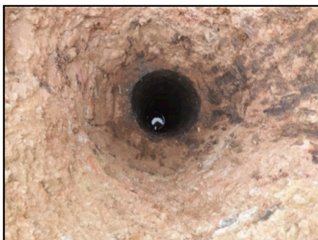
Fig. 5. Perforación de 6 metros de profundidad (sondeo # 3)
