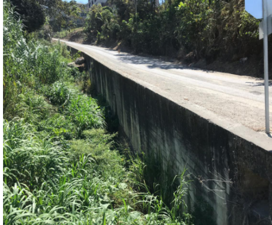
Fig. 5. Muro de Contención de Hormigón Armado.
