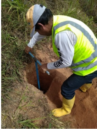
Fig. 15. Perforación 1 realizada con posteadora manual.
