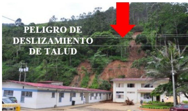
Fig. 1. Deslizamiento de tierra al pie del talud del cerro Pata Grande.
