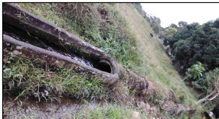
Imagen 6. Canal embaulado y tubería de hormigón
